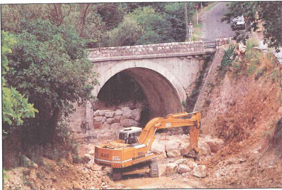
Photo n° 11 : Travaux de recalibrage après les crues de juin 1994. Vallée de la Frayère (Alpes Maritimes)
