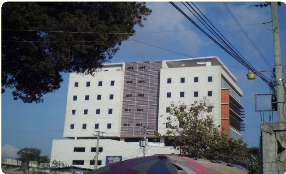
Photo 3 : Façade ouest du nouveau bâtiment logeant le Ministère de l'Intérieur et des Collectivités Territoriales (MICT) Rue Paul VI. (Crédit photo : Jean Odile ETIENNE, 2017)
