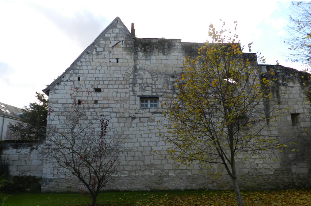
Fig. 10 : Mur à baies romanes du parc des logis royaux
