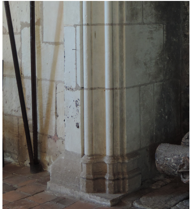
Fig. 50 : Cheminée de la grande salle des logis royaux, détail des moulures.
