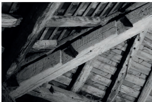
2. sablière réemployée comme arêtier avec ces entailles en demi-queue d'aronde
