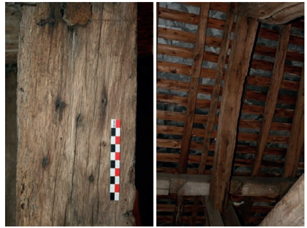
2. traces de clous en sous face des arbalétriers correspondant à la pose d'un lambris avec des couvre-joints.
