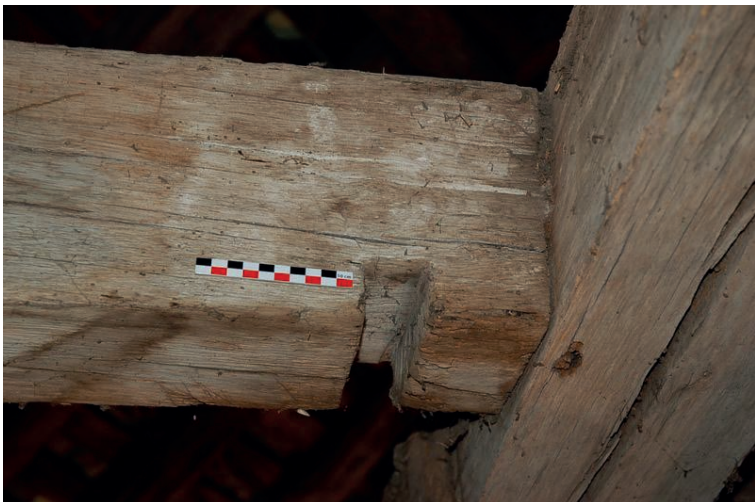
1. Entaille sous l'entrait pour l'accroche sur une sablière à languette.
