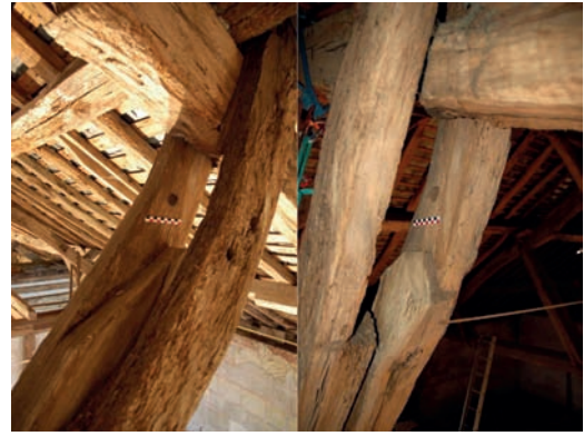
2. Echarpes réemployées comme contrefiches. l'entaille à mi-bois permettait l'assemblage avec un entrait retroussé.
