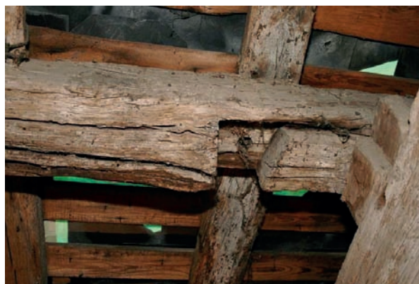
3. Queue d'aronde sur un chevron permettant son assemblage à mi-bois avec un entrait retroussé ou une contrefiche. Des clous sont encore visibles sur la face supérieure.
