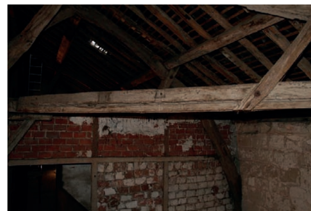
4. Entrait roman avec sa rainure et ces entailles à mi-bois, réemployé comme coyver dans la charpente actuelle.
