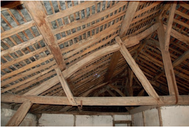
1. Entrait retroussé réemployé comme arbalétrier dans la charpente actuelle.
