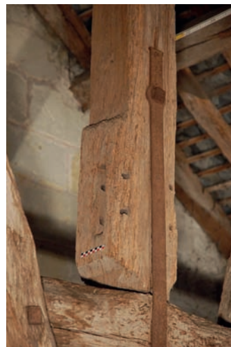
3. Partie restante d'un poinçon, avec des mortaises accueillant des pièces placées longitudinalement à la charpente
