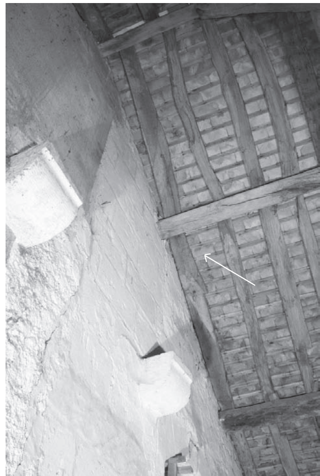
5. Entrait retroussé réemployé comme chevron dans la charpente actuelle. les deux entailles à mi-bois sont bien visibles.
