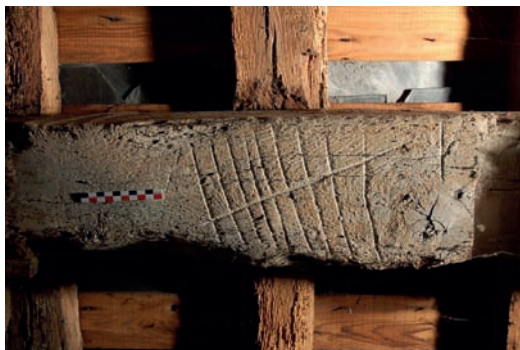
3. Marque n°91 indiquant la présence d'au moins 91 fermes dans la charpente d'origine
