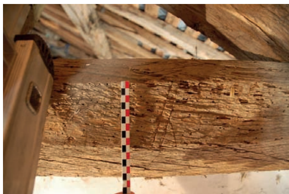
4. Les arêtes des entrails sont chanfreinées. On remarque ici une marque d'appartenance à la deuxième ferme de la charpente actuelle de l'hôtellerie.
