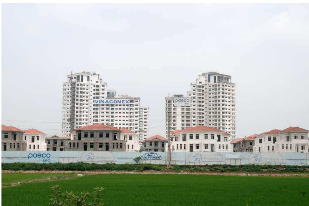
FIGURE 7.2: Splendor : une ville nouvelle en construction
