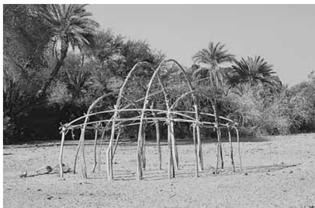
Structure en arceaux de la tente de l'Aïr
