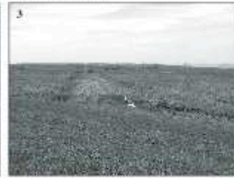
Photo 3 (L. Goeldner, août 2006) : seize ans après la brèche, l'ancien digue séparant le polder Selexa de l'Écluse occidentale est à peine visible au sein d'une phragmitaie très uniforme. / Sixteen years after the breach, the former dike separating the Selexa's polder from the Western Scheldt is not easy to detect, inside a uniform reedbed.
