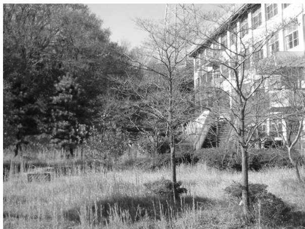
Ecole désaffectée à Tama
