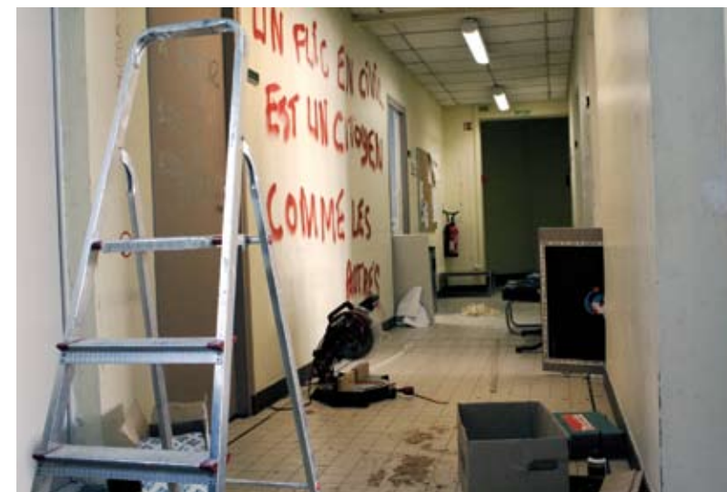
Fig. 28. Remise en état des lieux, 7 avril 2006.
