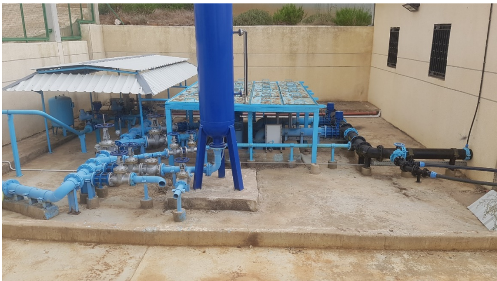
Fig. 26 - La station de la source Barghach à Hrar (Ahmad KAMALEDDINE, 21/09/2020)
