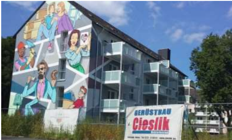
69 Dortmund, 24/08/2021, MIR. Travaux de rénovation avec pose de balcons, changements de vitre...
