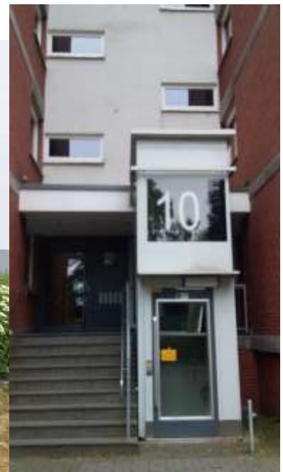
71 Dortmund, 17/08/2021, MIR. Ascenseur après réhabilitation DogeWo21
