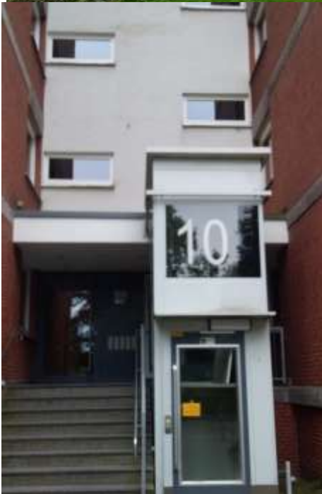
43Dortmund, 18/08/2021, MIR. Adaptation des parties extérieures après réhabilitation
