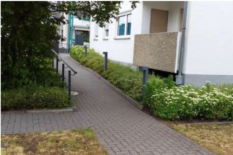
70 Dortmund, 23/06/2021, MIR. Rampe d'accès après terrassement Dorsfeld-Dortmund WSG.
