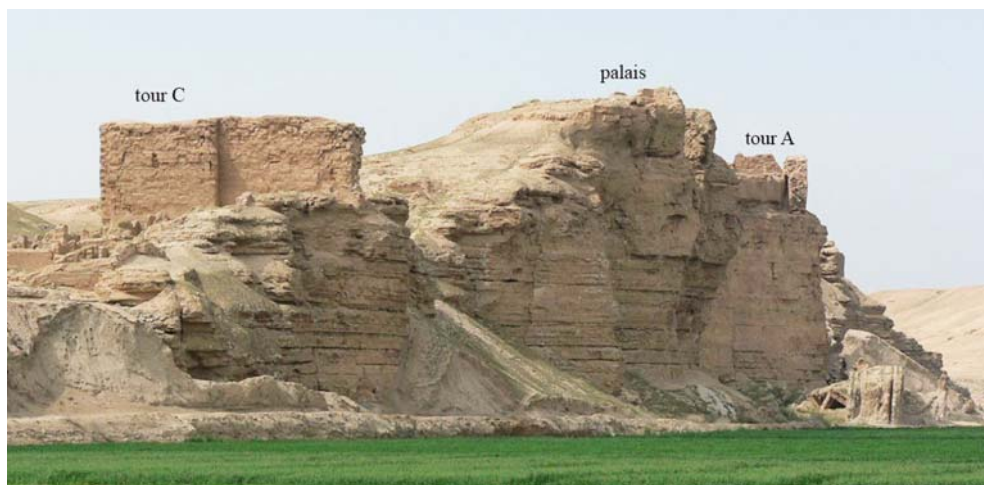
Fig. 19 – Citadelle : falaises et ancrage du mur nord-ouest de la tour A (MFSED).
