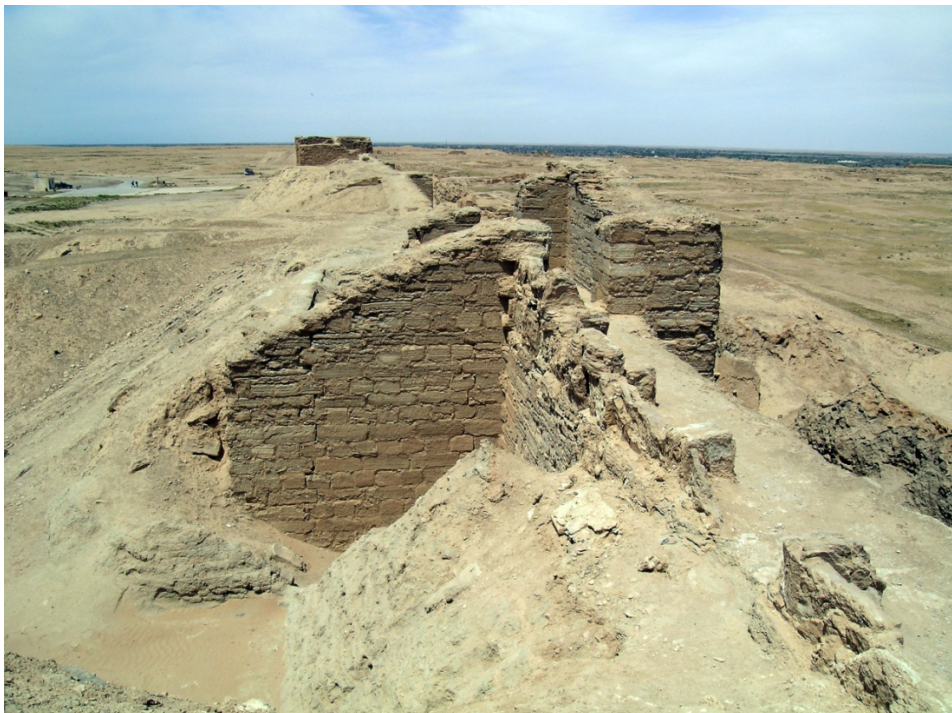
Fig. 31 – Vue du glacis extérieur près de la tour 15. (cliché MFSED)
