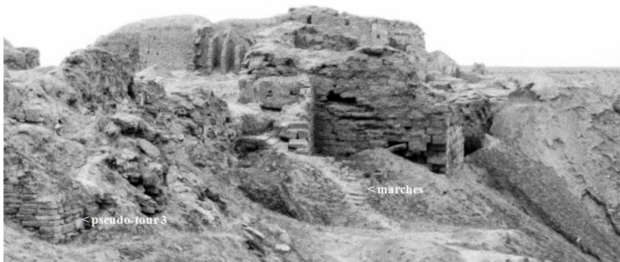
Fig. 74 – Le rempart à l'Est de la tour2 (MFSED).
