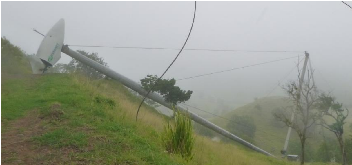
Photo 25 : Les éoliennes du Vauclin couchées pour maintenance.
