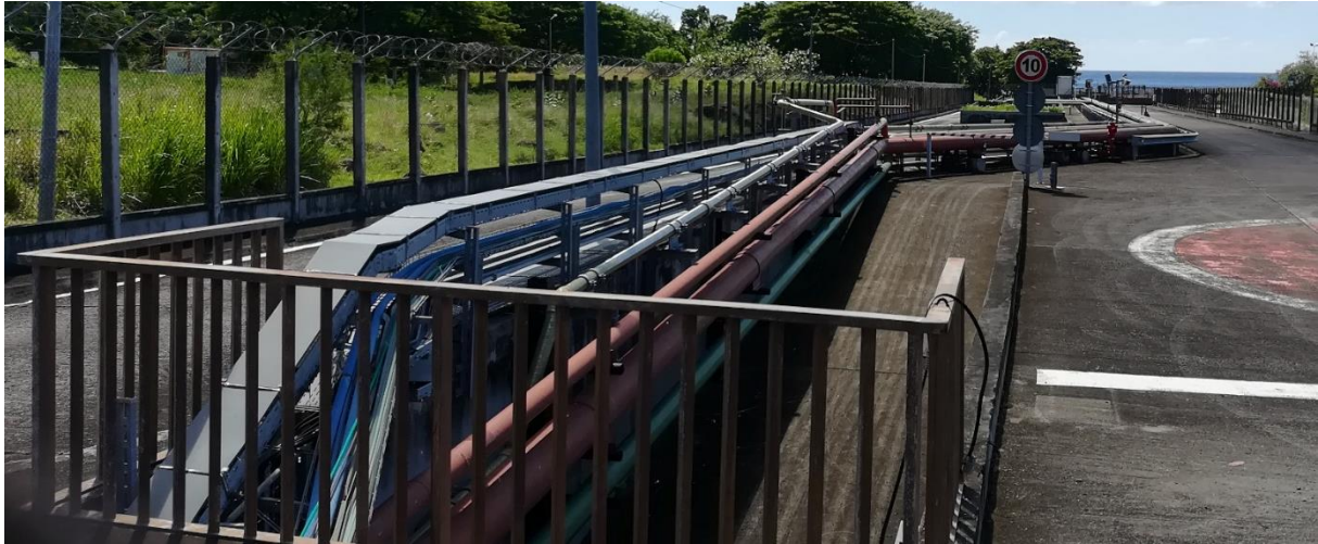
Photo 4 : Interface mer-centrale à Bellefontaine permettant l'approvisionnement pétrolier. Auteur : François Ory, 2018.
