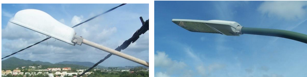
Photo 6 : Vieux luminaire (gauche) et nouveau luminaire LED (droite). Auteur : Service Technique de la commune de Rivière-Salée, n.d.
