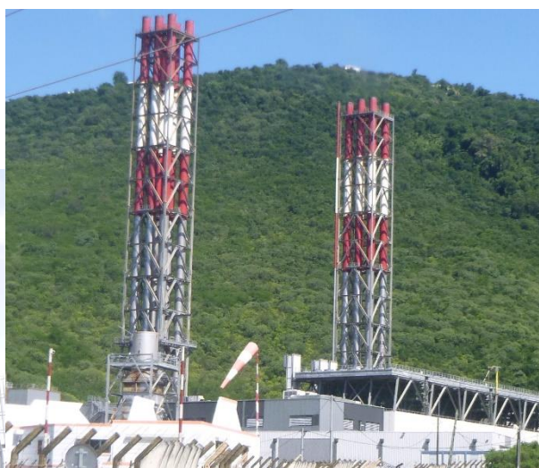
Photo 8 : Les cheminées de la centrale de Bellefontaine 2, sur la côte Caraïbe de Martinique. Auteur : François Ory, 2018.
