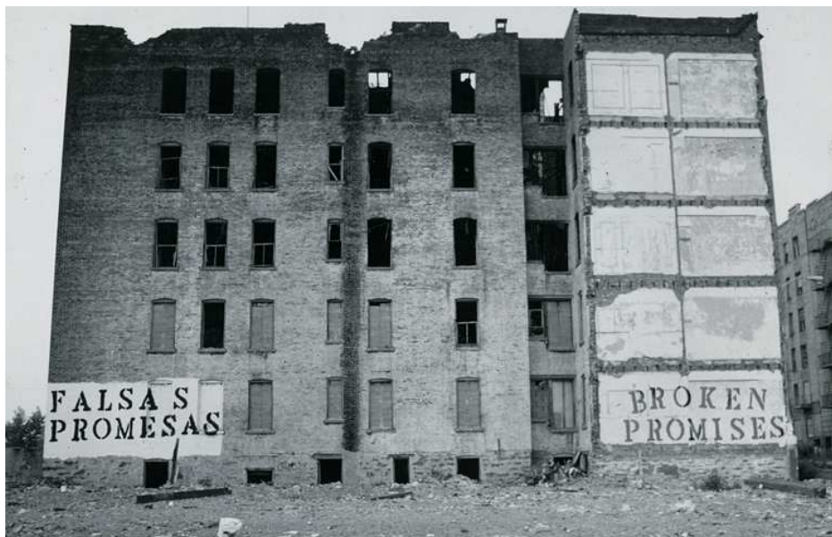
Photo 11 : Les promesses non tenues. Immeuble du South Bronx devant lequel Jimmy Carter (en 1977) et Ronald Reagan (en 1980) ont fait campagne.
