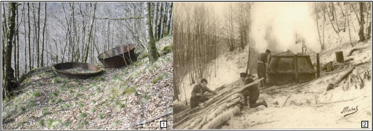
Figure 33 : Le charbonnage en four métallique mobile : 1 : Exemple d'un vestige de four dans la vallée de la Luzège sur une ancienne plateforme de charbonnage en meule – 2 : Four Magnein en fonctionnement dans les pentes de la Luzège pour les chantiers de jeunesse (Pesteil F., collection privée).
