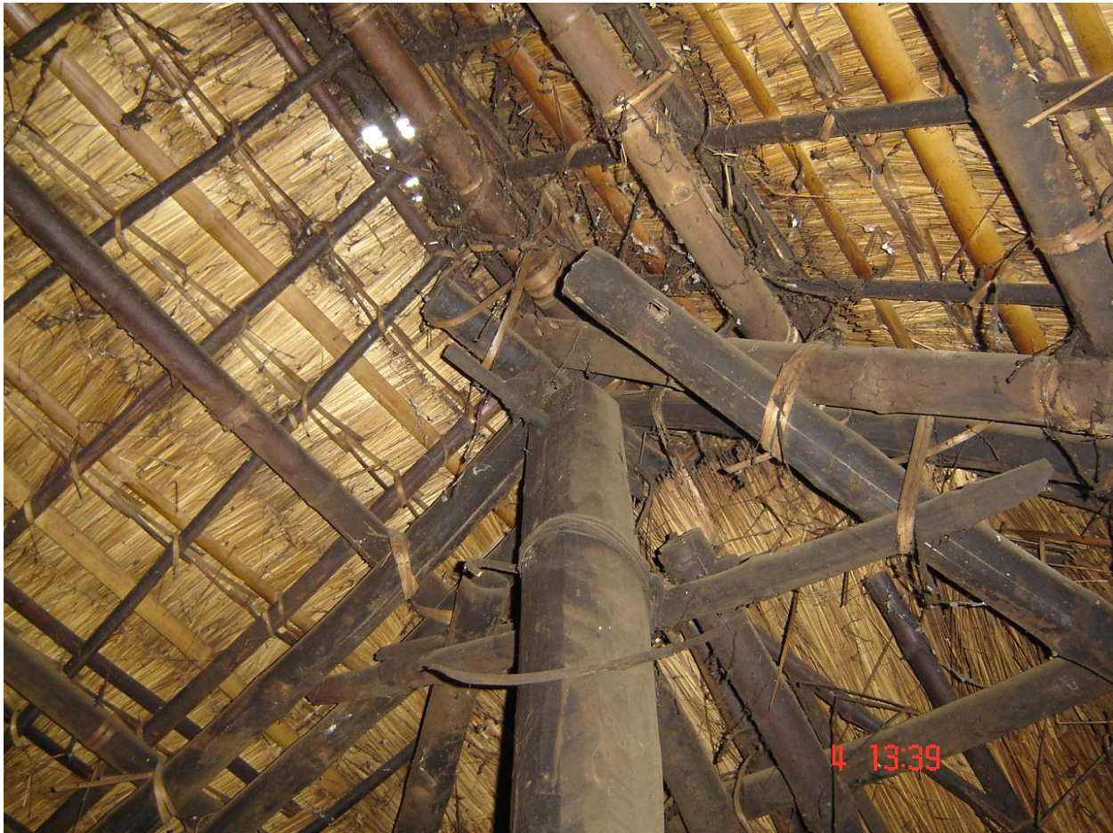
Figure 10 : Maison rudimentaire mais charpente savante
