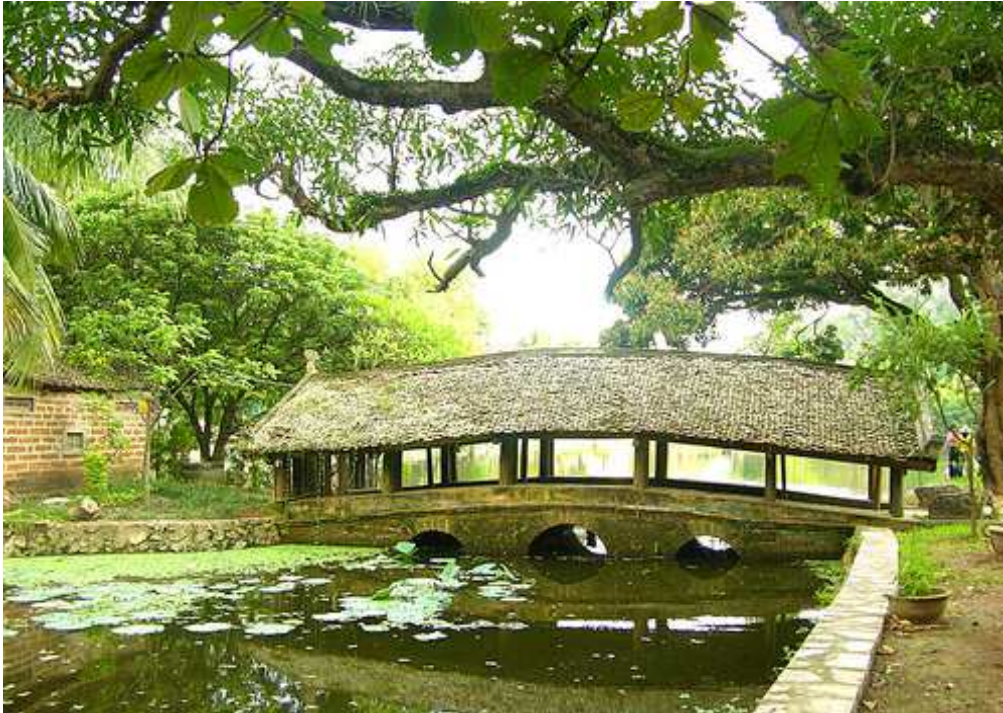
Figure 50 : Le pont de Ngói Thanh Toàn
