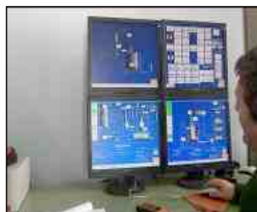
Photo 144 – Salle de contrôle
