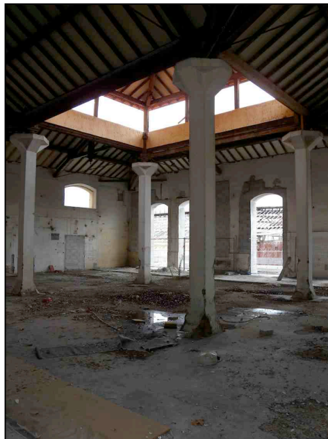
De gauche à droite : photos 112 et 113 – ancienne salle de distillerie de l'usine Roure, photo 114- extérieur de la salle de distillerie de l'usine Roure
