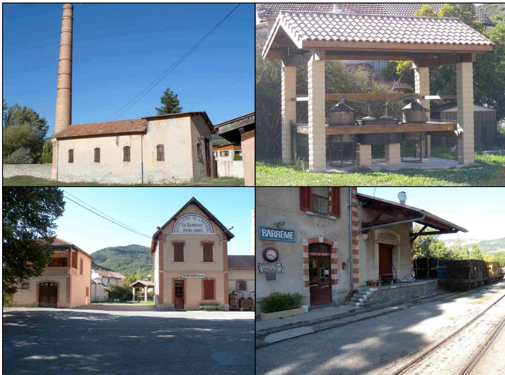
Photo 100 (haut, gauche)- Salle de distillation et cheminée Photo 101 (haut, droit) – Cuves d'époque Photo 102 (bas, gauche) – Vue d'ensemble de la distillerie Photo 103 (bas, droite) – Chemin de fer et gare de l'époque © 2009 RM
