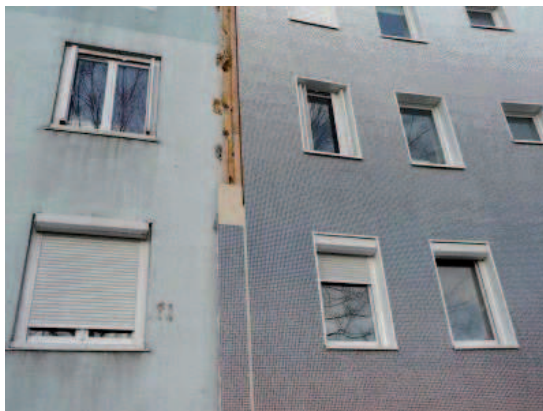
Le Serpentin retrouve des couleurs en 2009 après que les appartements aient été rénovés et l'isolation extérieure refaite. Source Chapitre : www.batiactu.com/ , consulté le 28 octobre 2011.
