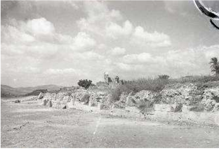
Photo A-1 : le mur de soutènement de l'esplanade B.
