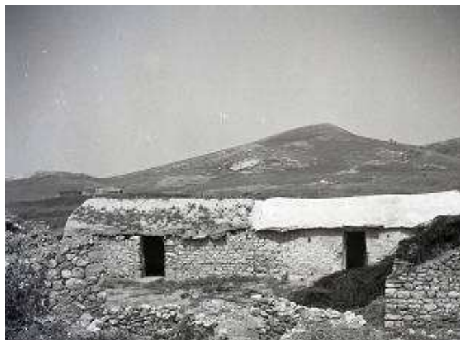
Photo A-5: l'habitat dans le secteur avant dégagement.
