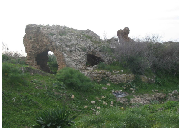
Structure de la cavea (photo de R. Zammel)
