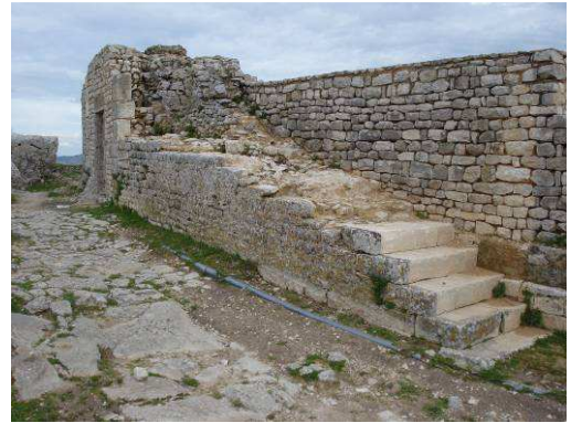
Structure de la façade postérieure de la cavea (photo H. Ksouri).
