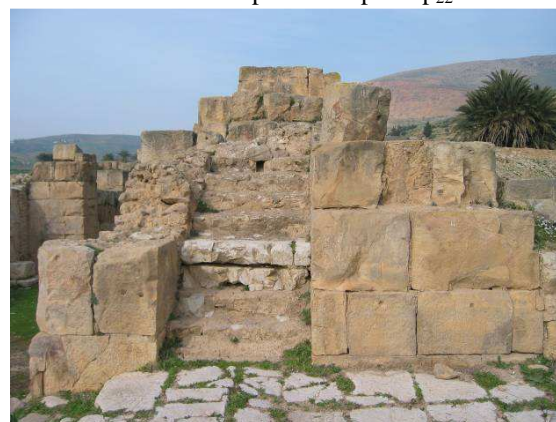
Photo 74 : Aspect de l'escalier situé à l'extrémité est du bâtiment de scène.
