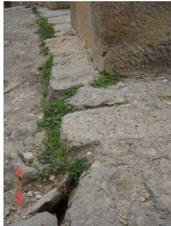
Photo 4 : Tracé de construction : ligne incisée indiquant la limite des piles de façade.
