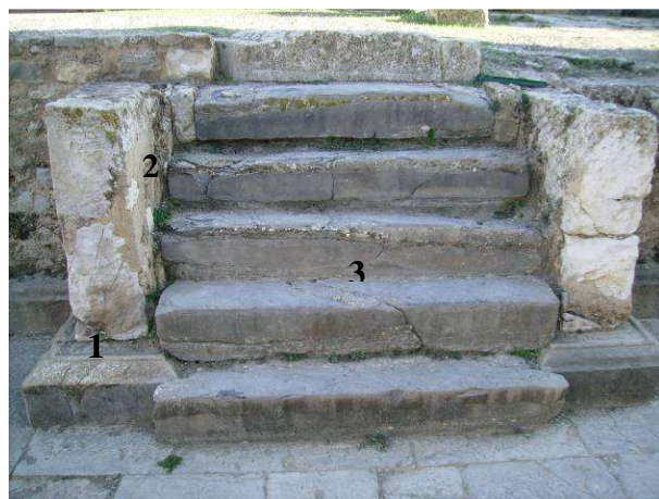
Photo 65: Aspect des escaliers est ( e 8 ) d'accès à la scène.
