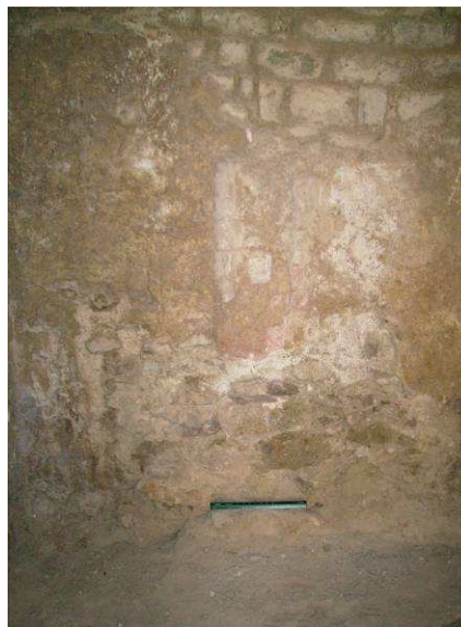
Photo 43: Détail de l'enduit du mur de fond de l'espace C 2 .
