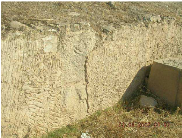
Photo 214 : Enduit de la paroi intérieure des murs de l'enclos nord.
