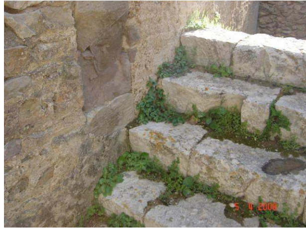
Photo 92 : juxtaposition du mur m 3 et des escaliers e2.
