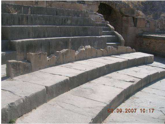
Photo 62 : Etat de conservation du mur de balteus .
