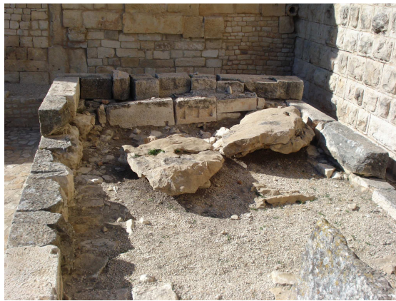
Photo 115 : Les murs de podium du temple dit de Massinissa à Dougga.
