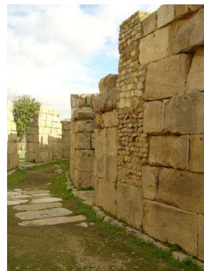
Photo23: Soubassement du mur m_2 .
