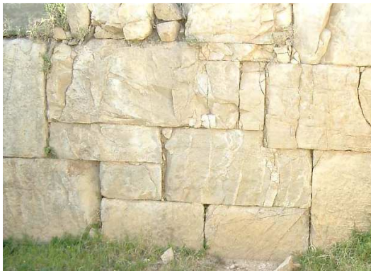
Photo 107 : Différentes positions de blocs en crossette.
