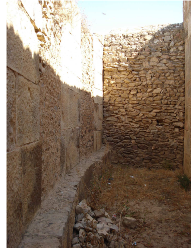
Photo 24: Etat actuel de l'espace B 1 .
