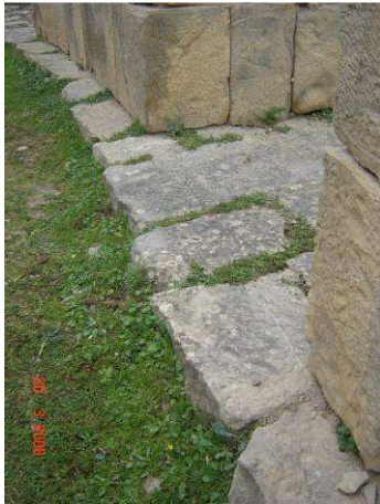
Photo 4 : Tracé de construction : ligne incisée indiquant la limite des piles de façade.
