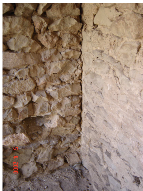
Photo 91: Juxtaposition des murs m_3 et m_6 .
