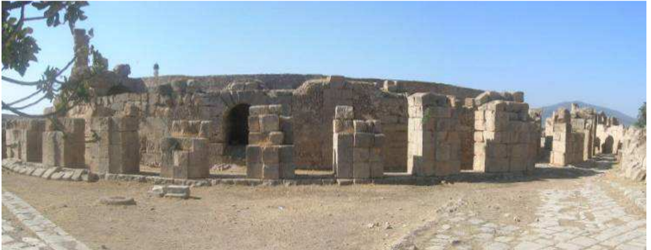
Photo 3: Aspect d'ensemble de la façade à partir du dégagement au nord-est.
