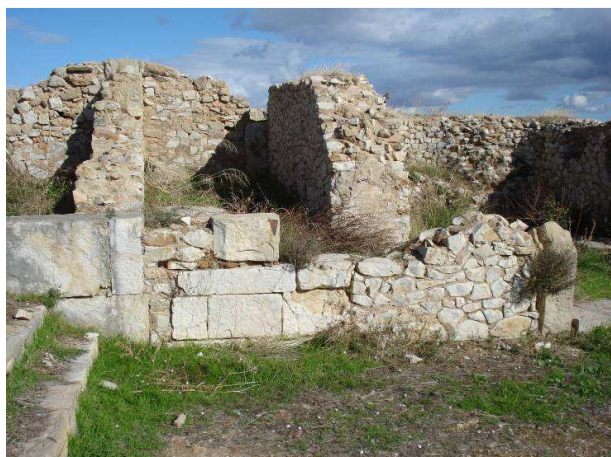
Photo 186 : Aspect mur de fond du portique.
