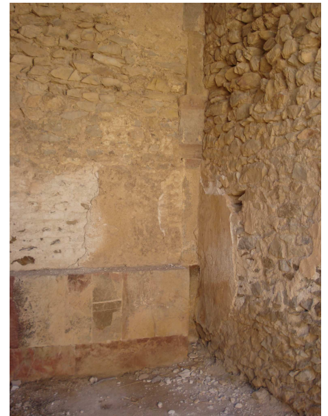
Photo 40: Aspect du soubassement dans l'espace B2.
