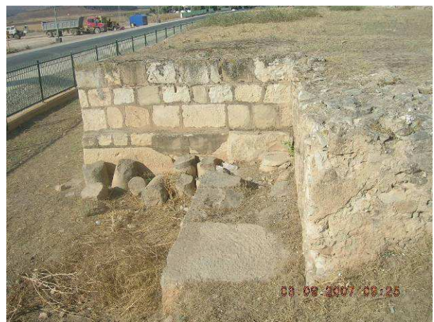
Photo 147 : Retour de l'angle est du mur de soutènement.
