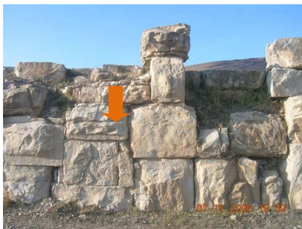
Photo 104 : les pierres de raccord sur le mur de soutènement de l'esplanade A.
