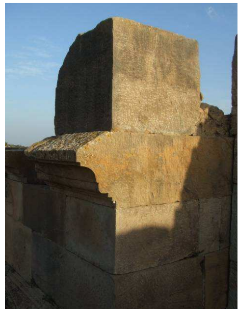
Photo 164: Aspect de la corniche du podium.
