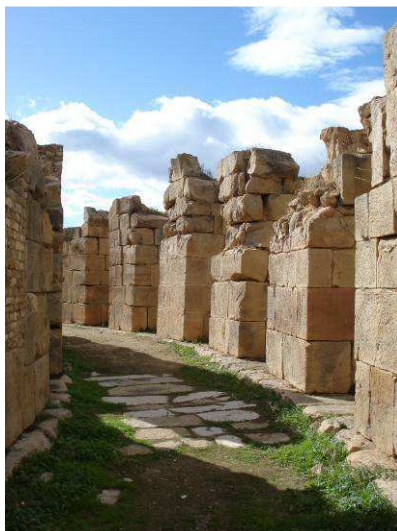
Photo20 : Face intérieure du mur m_2 .
