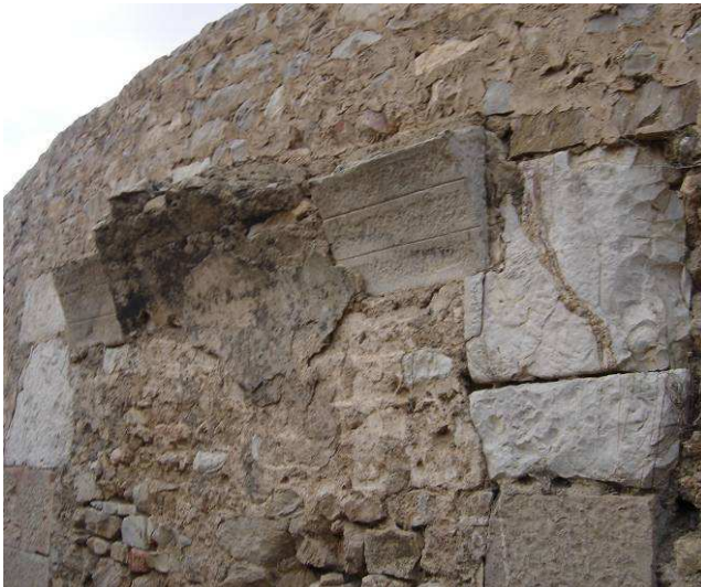
Photo25: Amorce d'une voûte située en face de la porte p 6 , prenant appui sur le mur m 3 .
