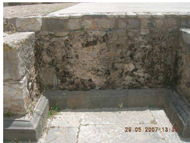
Photo 64 : Exèdre et renforcement à fond plat.
