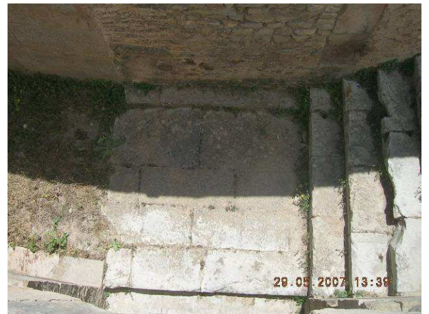
Photo 32: palier situé devant la porte d'accès à l'espace B4 .
