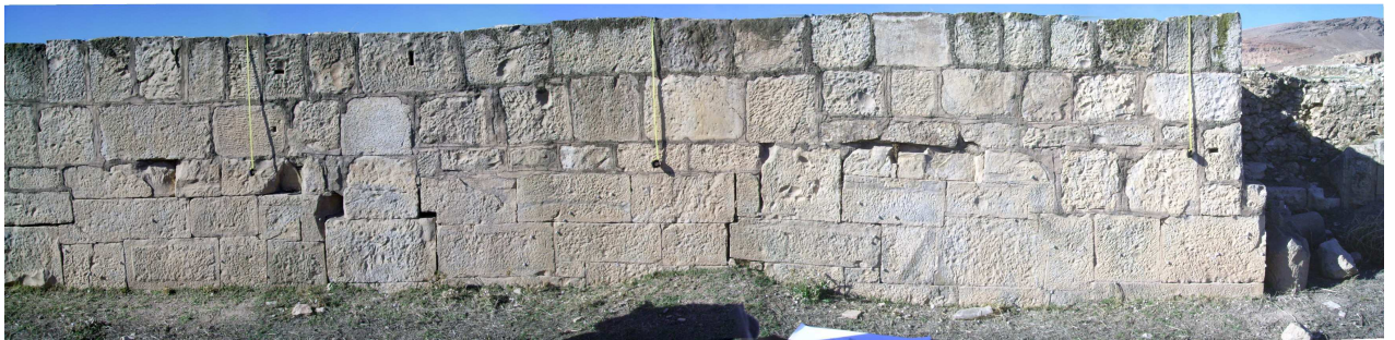
Photo112 : aspect du mur de soutènement de l'esplanade B
