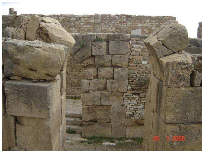
Photo 9: Aspect des arcs de façade conservés.
