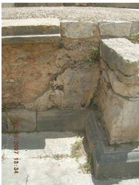
Photo 69 : Enduit de revêtement de la niche rectangulaire ouest.
