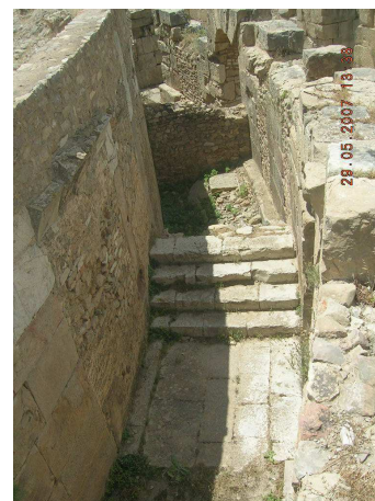
Photo35: volée de l'escalier e 4 .
