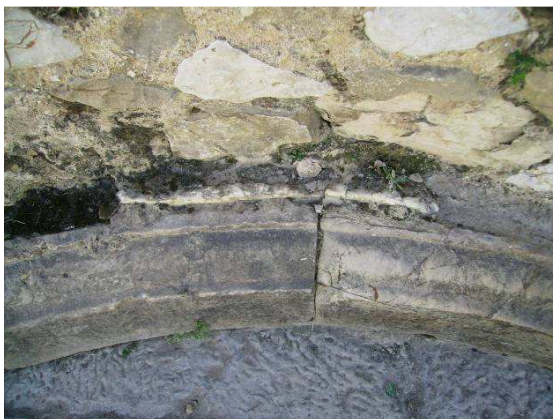
Photos 66-67: fragment d'une plaque de revêtement en marbre logée dans la rainure de la plinthe.
