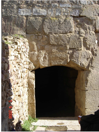
Photo28: Aspect de la porte p10 .
