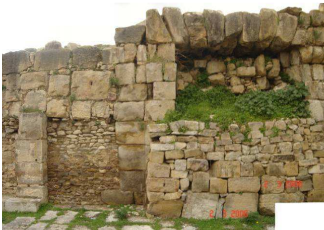
Photo 80: Aspect de la porte ouest de la basilica orientale ( p_{22} ), bouchée à l'époque byzantine.
