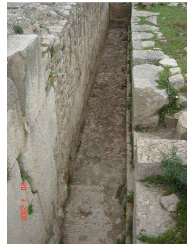
Photo 155 : La façade postérieure du podium du temple B.
