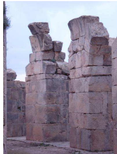
Photo 21: Départ des voûtes de l'ambulacre sur les piles pi_2 et pi_3
