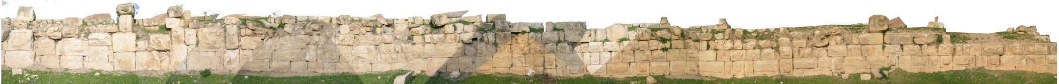
Photo 106 : Montage photographique d'ensemble du mur de soutènement de l'esplanade A.
