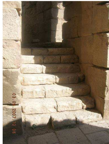
Photo 50: Les escaliers de la porte p 12 .
