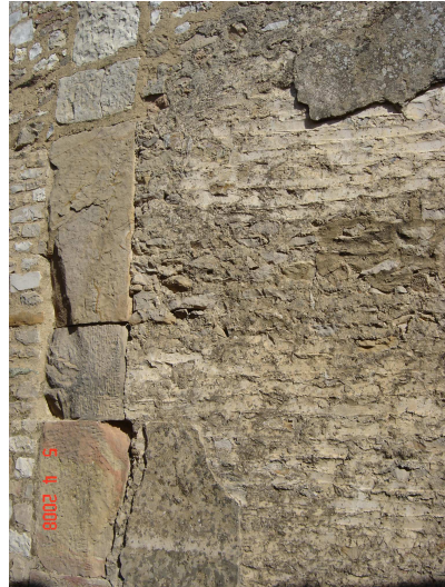
Photo 38: Aspect des harpes constituées d'une seule rangée de blocs.
