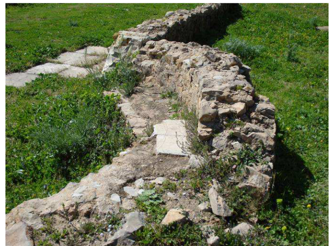
Photo 217: les restes du revêtement de l'exèdre du bassin planté nord.
