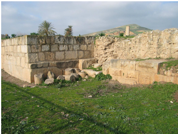
Photo 110 : le retour d'angle du mur de soutènement de l'esplanade B.
