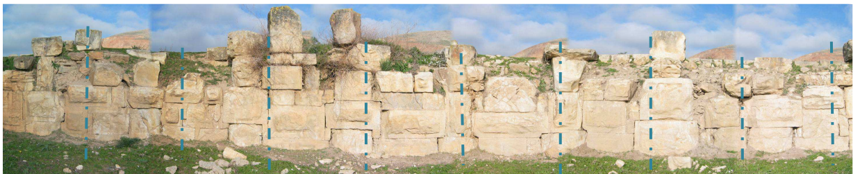
Photo 113 : Montage photographique de la partie ouest du mur me 1 de l'esplanade A.
