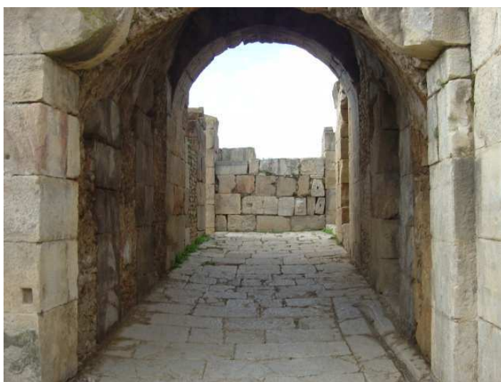
Photo52 : Aspect du dallage du passage ouest. Au fond le mur mitoyen avec le temple E.
