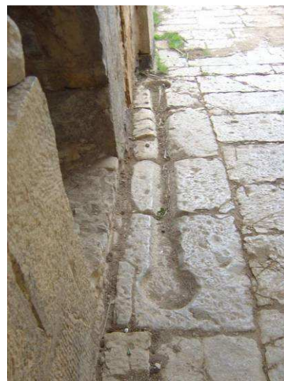
Photo 53: Aspect de la rigole du passage ouest.
