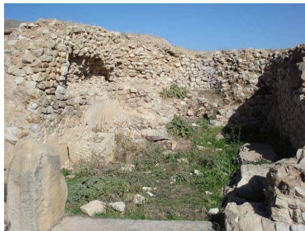
Photo 185 : Aspect du mur du fond avec niche semi-circulaire.
