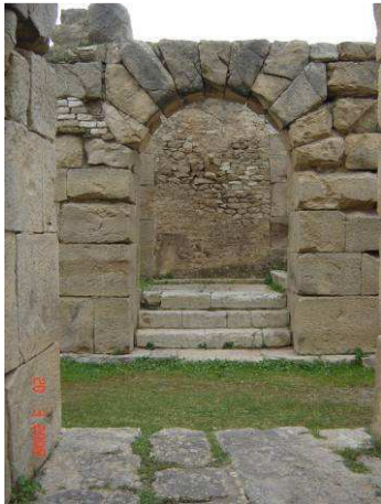
Photo30: la porte p3 d'accès à l'espace B3 . PO3
