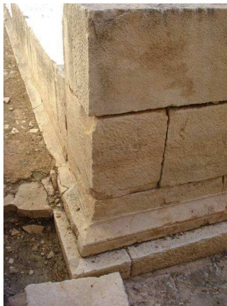
Photo 156 : Aspect de la moulure de base du temple de Massinissa à Dougga.
