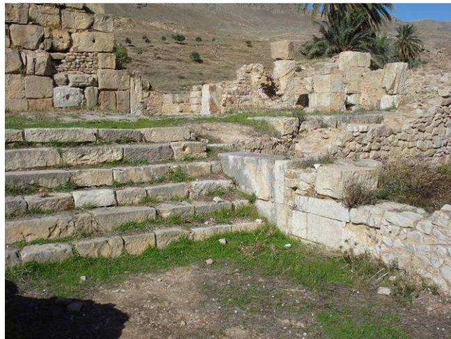
Photo 77 : Escaliers d'accès à l'extrémité est du portique (e 13 ).
