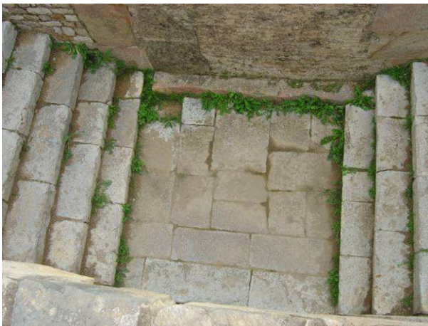
Photo31: palier situé devant la porte d'accès à l'espace B3 .
