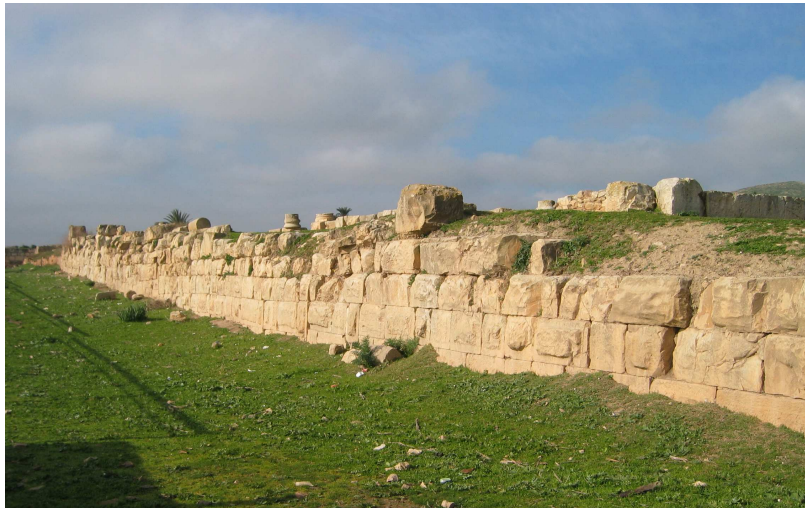
Photo 109: Aspect du mur ( me_1 ) de soutènement de l'esplanade A.
