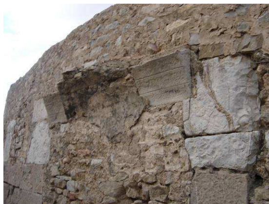
Photo 99: E 4 départ de la voûte supportant le vomitorium.
