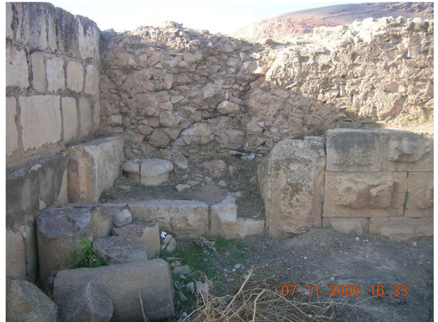
Photo 111 : Détail du raccordement de l'extrémité de l'esplanade B avec le mur de soutènement de l'esplanade A.
