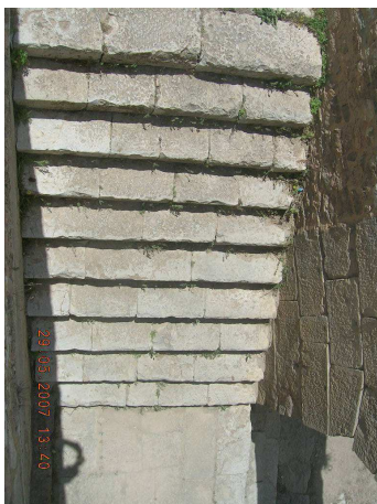
Photo33: Volée de l'escalier e 2 .
