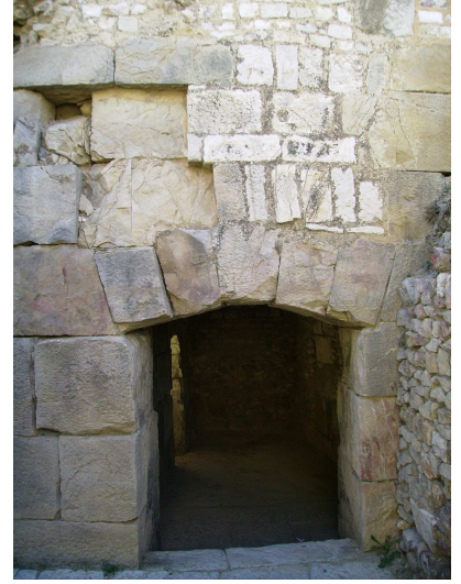
Photo29 : Aspect de la porte p9 .
