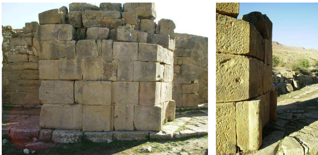
Photo 8: Aspect des piles encadrant les entrées de la rue traversante. Photo 6: Détail du chasse-roue.
