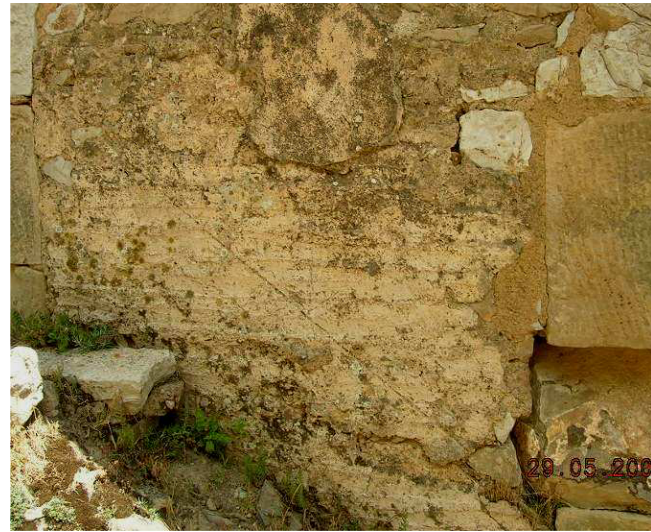
Photo26: Tracé incisé du profil de l'escalier.
