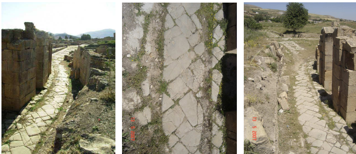
Photos 15-16-17 : Aspect des dalles de la moitié nord. de la rue qui longe le théâtre
