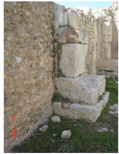
Photo 84 : détail de construction d'un pilastre.
