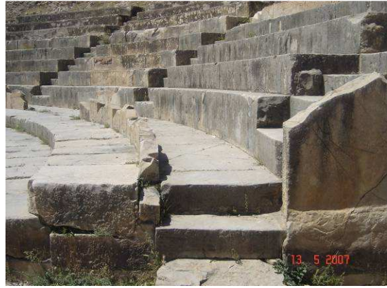
Photo 63 : Ancrage du balteus du côté est.
