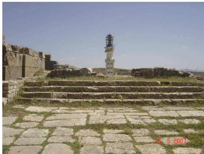
Photo 203: Aspect des marches conservées de l'escalier de façade.
