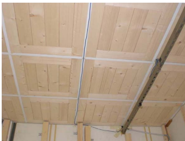
Figure 4-9 : plafond en bois
