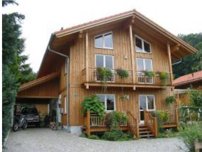
Figure 1-6 : Maison en panneaux de bois massifs contrecollés
