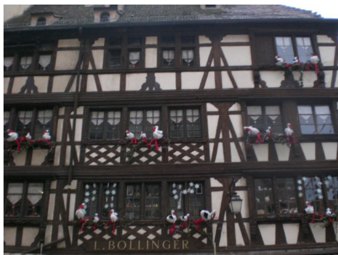
Figure 1-3 : Maison à colombage alsacienne (Strasbourg)
