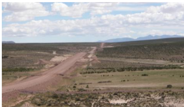
Photo 11 : Piste en cours d'aménagement entre Salinas et Challapata
