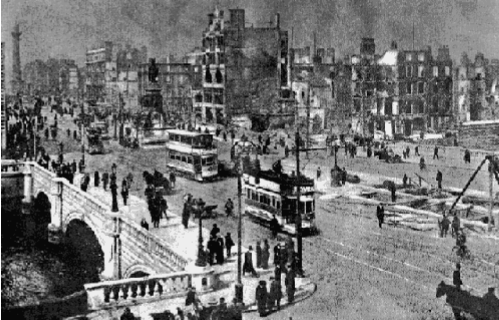
Figure 14 : Les tramways circulent de nouveau sur le pont O'Connell après le "Easter Rising", mai 1916. Au fond, on distingue les immeubles détruits dans les combats.
