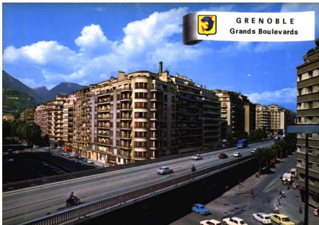
Figure 37 : L'autopont du carrefour Vallier/Jaurès, inauguré en novembre 1967. Quand les cartes postales vantaient la modernité automobile de Grenoble...
