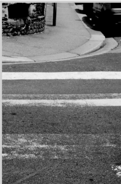
Un trottoir aménagé en "bateau" Le Havre, 2009
