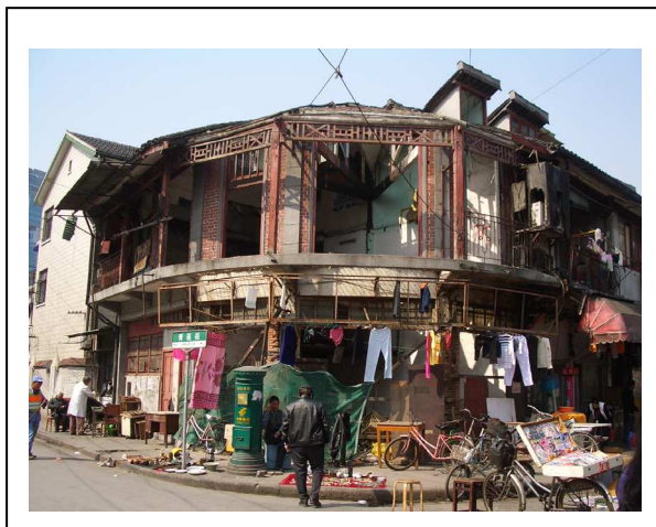
Photo 10 : Logements démolis et logements en attente de démolition dans un même bâtiment, sur la Fang Bang Lu
