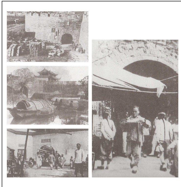
Photo 6 : Les remparts, les douves et les portes de la Vieille Ville datant de la Dynastie Ming
