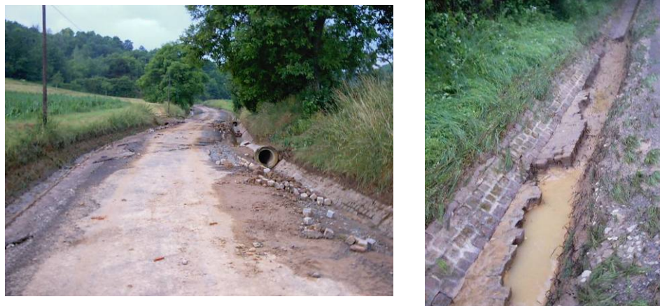
Figure 2.12 : Atteinte au réseau d'écoulement lors d'une coulée boueuse à Soultz les Bains (Alsace – Clichés : Région Alsace, 2003)
