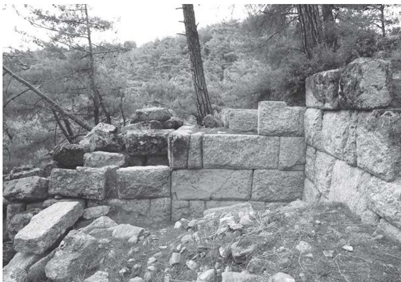
Fig. 50 : Jonction mur d'enceinte/Tour 2 (B. Vergnaud).
