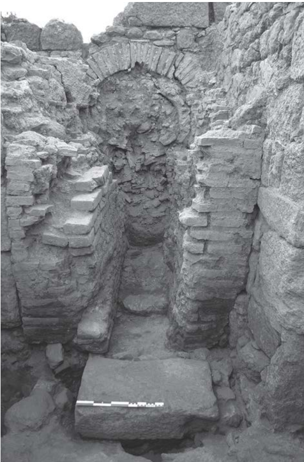
Fig. 93 : Dalle de pierre posée devant le foyer (US8031), depuis l'Est (Chr. Bost).
