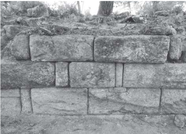
Fig. 47 : Appareil à carreaux et boutisses du mur sud de la Forteresse Haute (B. Vergnaud).
