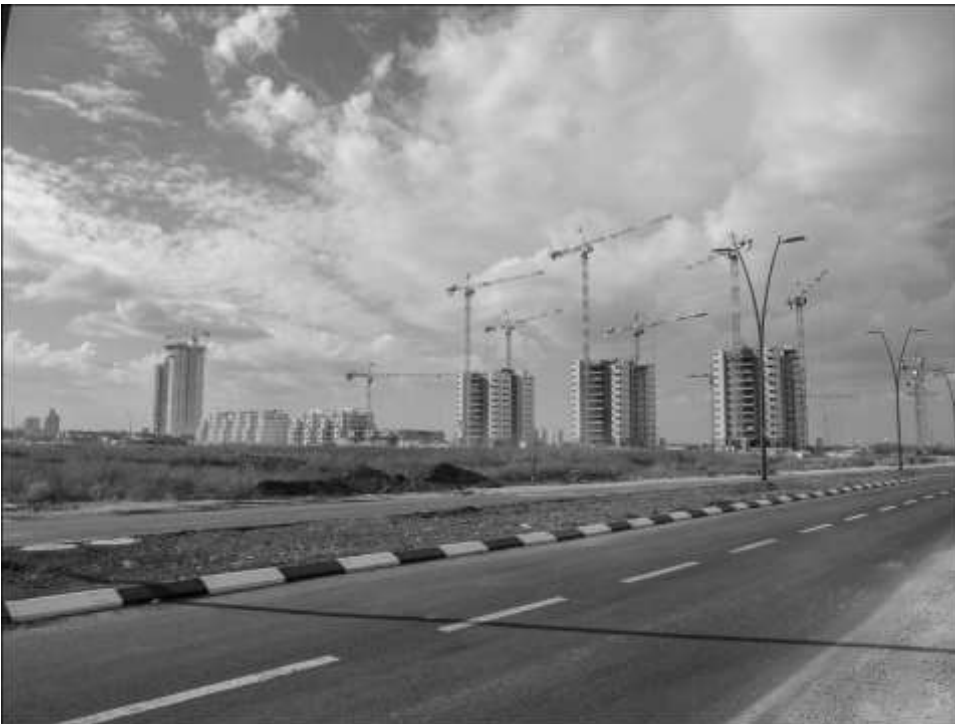
L’image, prise au nord de Kiryat Gat, non loin du nouveau site de Karnei Gat, montre l’avancée des travaux et la nouvelle ligne d’horizon de la ville, bien différente des anciens ensembles de logements publics.
