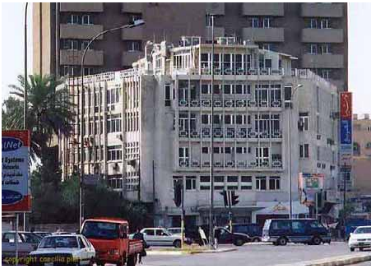
ill.21, 22, 23. Immeubles-îlots des années 50 : Wathiq Square, quartier Battaween, Masbah Square. © C. Pieri
