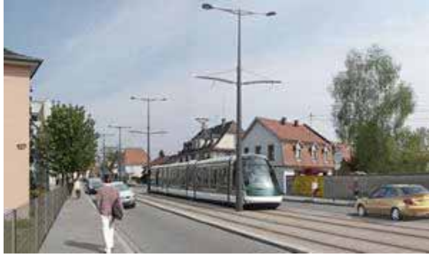
Une vue au sol, d'une rue située dans un quartier périphérique de Strasbourg, transformée grâce à l'implantation du tramway (CM, n°22, juillet-août 2003).
