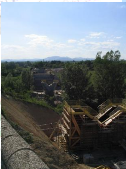
Travaux sur la N102, photo CERMOSEM
