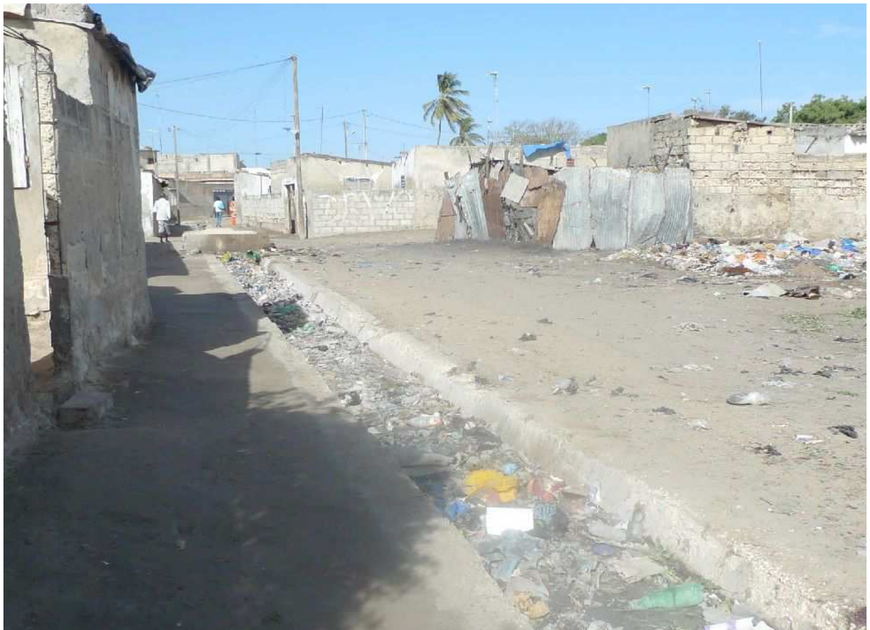
Photographie 82 : Petit canal bouché par des déchets plastiques, quartier Guendel
