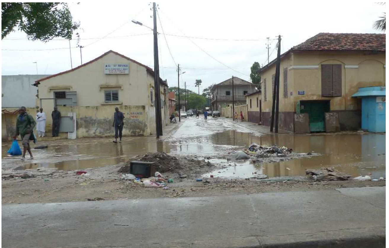
Photographie 87 : Rues inondées du quartier Keury Kaw
