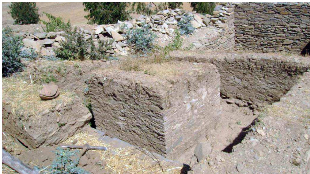
Phot. 12 – Secteur 1, bâtiment D2 : le pilier central de la pièce 1053 encore en place en 2007 (phot. H. Mekonnen).
