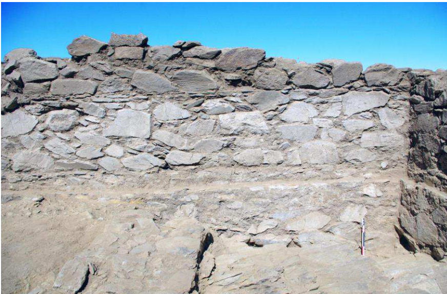
Phot. 29 – Secteur 2, bâtiment B2 : fondations des murs nord et est (M 2018 et M 2004) de la pièce centrale (phot. J. Charbonnier, 2012).
