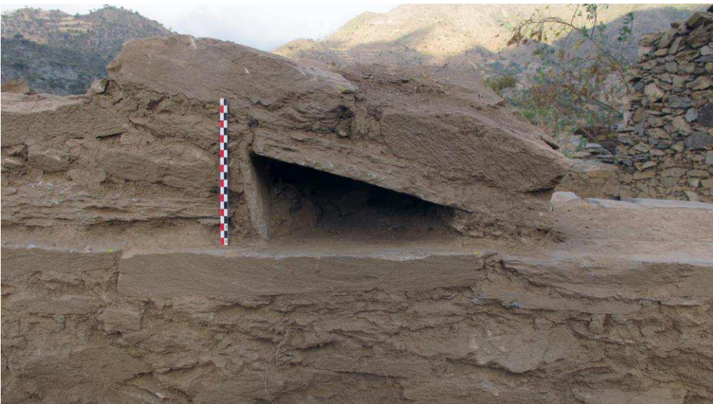
Phot. 15 – Secteur 1, bâtiment D2 : négatif de la poutre engagée sous le piédroit nord de la porte ouvrant sur la partie supérieure de la pièce 1053 (phot. X. Peixoto, 2012).
