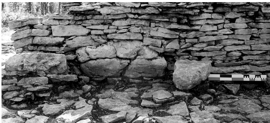
Fig. 8. Blocs lapiazés de calcaire Comblanchien dans une paroi de la ferme 2 (cliché P. Beck).
