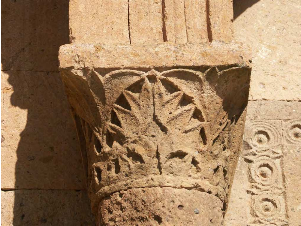
Fig. 160 – Portail ouest, piédroit gauche. Cliché de P. Donabédian, CNRS-LA3M/UMR 7298, 2013.
