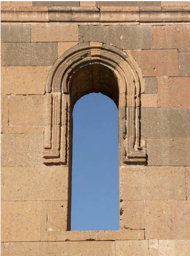
Fig. 129 – Façade est, fenêtre absidiale. Cliché de P. Donabédian, CNRS-LA3M/UMR 7298, 2013.
