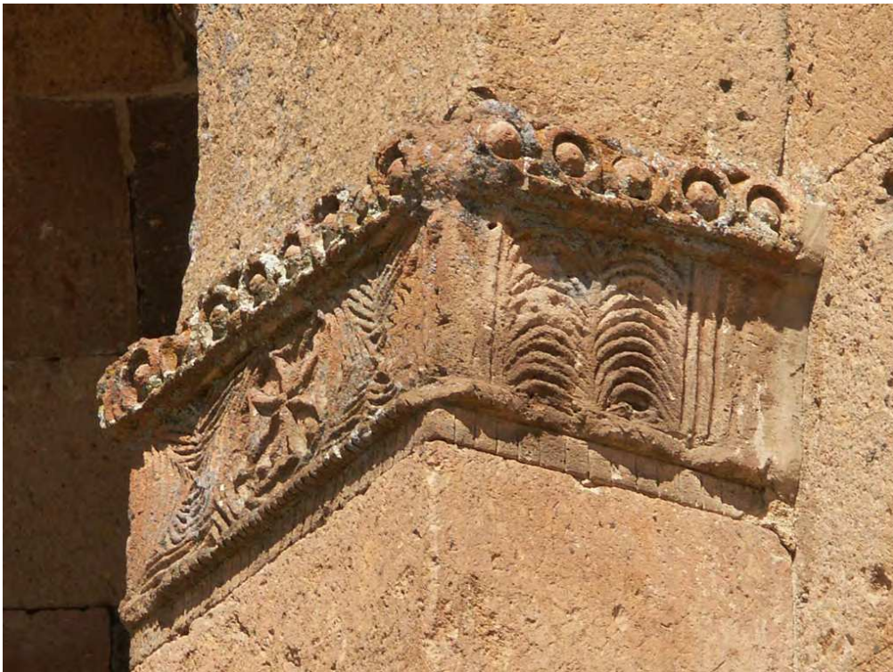
Fig. 159 – Galerie sud, pilastre au sud de l'abside, face sud-ouest. Cliché de P. Donabédian, CNRS-LA3M/UMR 7298, 2013.
