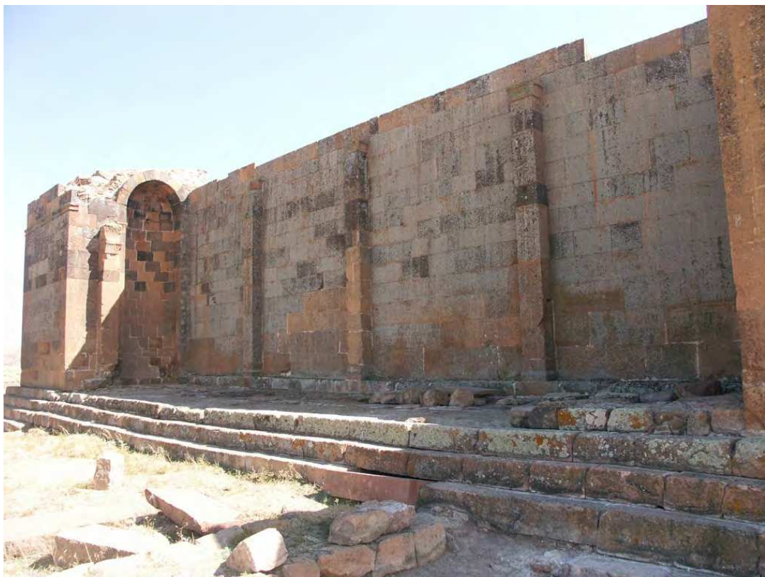
Fig. 113 – Façade et galerie nord de la basilique, depuis le nord-ouest. Cliché de P. Donabédian, CNRS-LA3M/UMR 7298, 2013.
