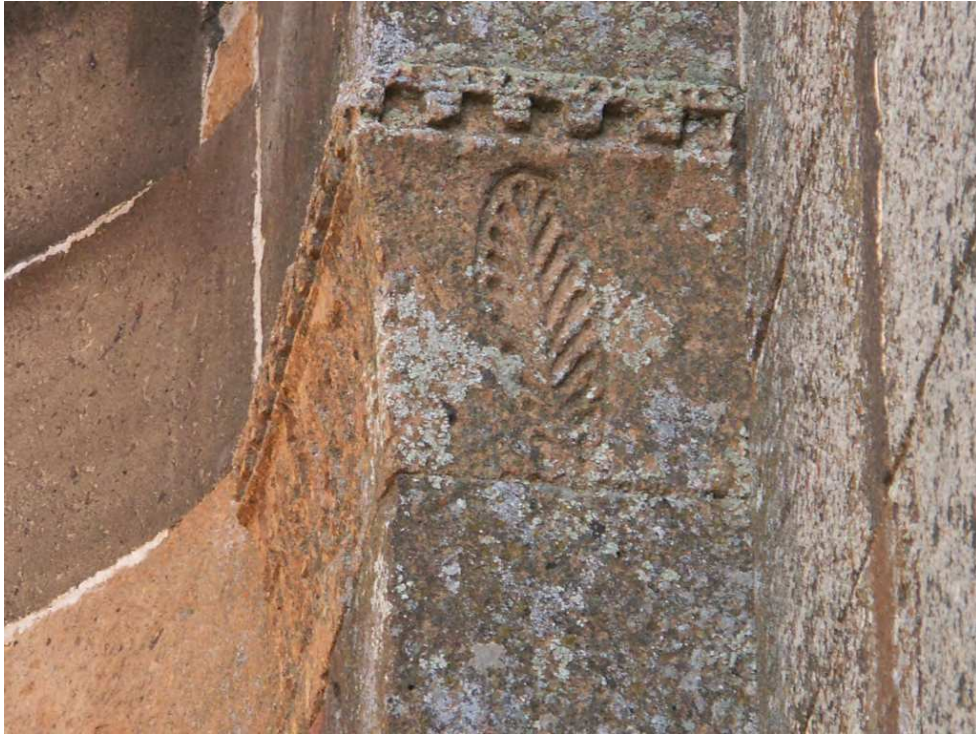
Fig. 156 – Galerie nord, abside, imposte sud, face ouest. Cliché de P. Donabédian, CNRS-LA3M/UMR 7298, 2013.
