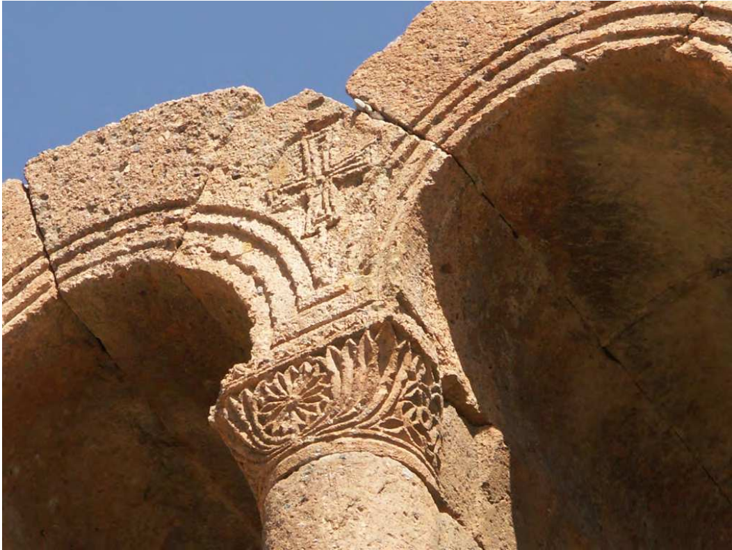
Fig. 164 – Façade ouest, fenêtre triple, trumeau gauche. Cliché de P. Donabédian, CNRS-LA3M/UMR 7298, 2013.
