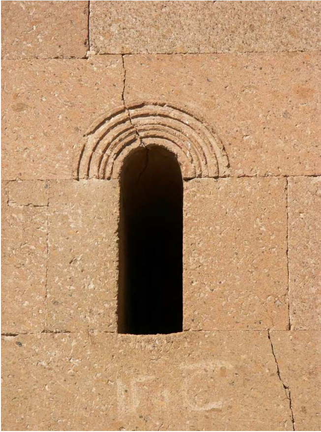
Fig. 130 – Façade est, fenêtre absidiale. Cliché de P. Donabédian, CNRS-LA3M/UMR 7298, 2013.
