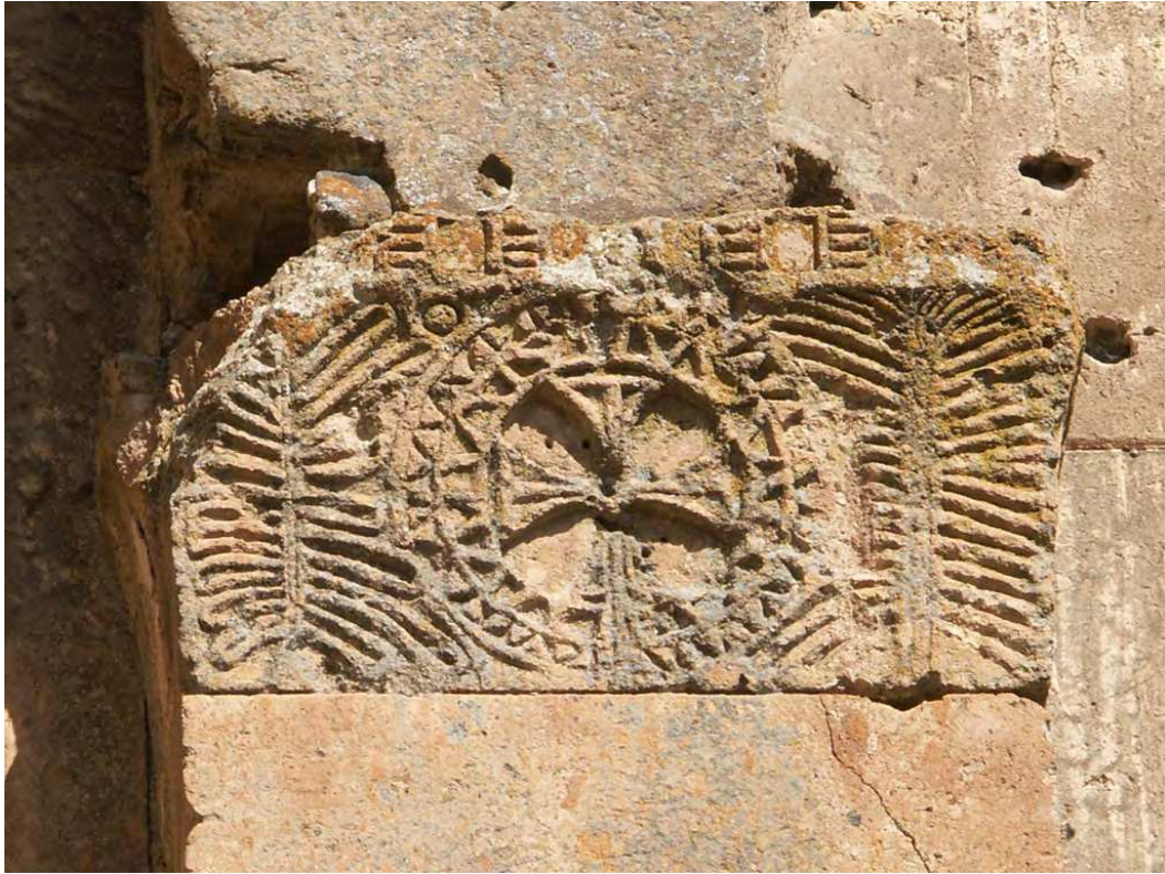
Fig. 148 – Pilastre au nord de l'abside principale, face ouest. Cliché de P. Donabédian, CNRS-LA3M/UMR 7298, 2013.
