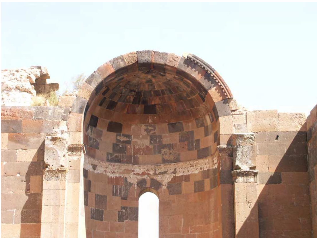
Fig. 109 – Voûte en cul-de-four du chœur de la basilique, depuis l'ouest. Cliché de P. Donabédian, CNRS-LA3M/UMR 7298, 2013.
