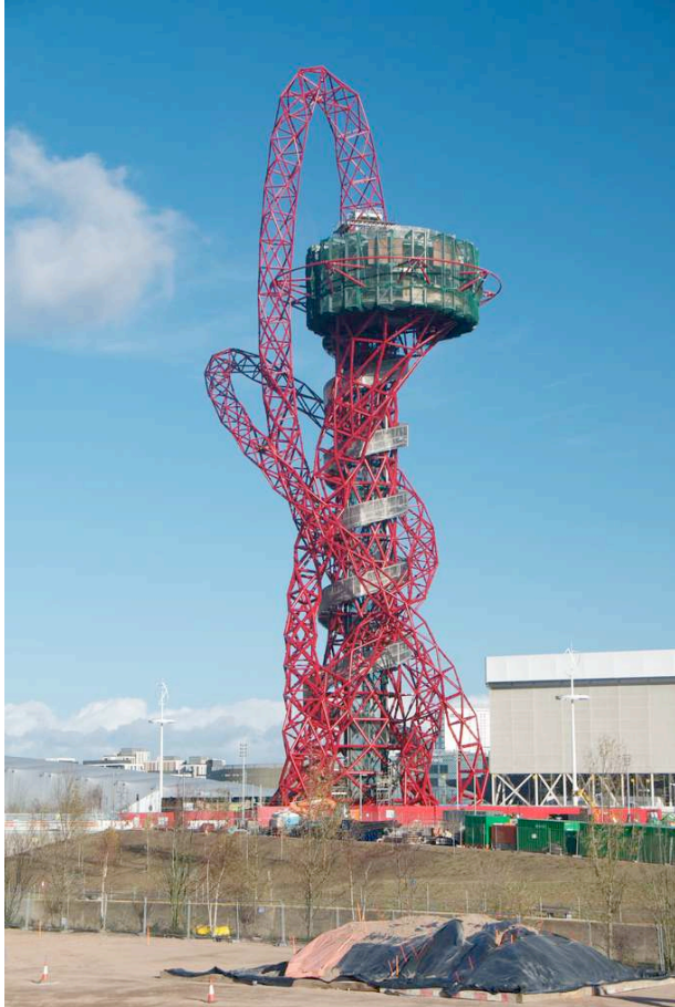
Photo 4 - La tour ArcelorMittal Orbit en novembre 2011. La double plate-forme d'observation est visible, enveloppée par des lacets d'acier et reliée au sol par un ascenseur.
