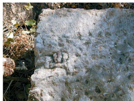
Vestige de scellement
