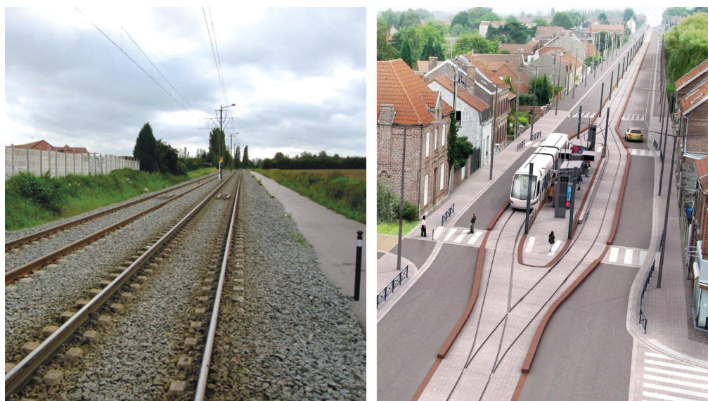
Figure 8 : Extension « low cost » des lignes de tramway dans le Valenciennois : voie en ballast vers Denain (à gauche, CETE Nord-Picardie), section à voie unique vers Condé (à droite, projet SITURV)
