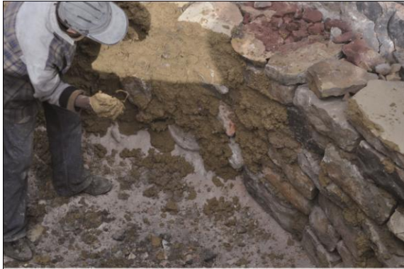
Fig. 7: Ouvrier en train de recouvrir la paroi d'un four à l'argile (Aïn Lansarine, E58, 2009 - cl.: Chr. Vaschalde).
