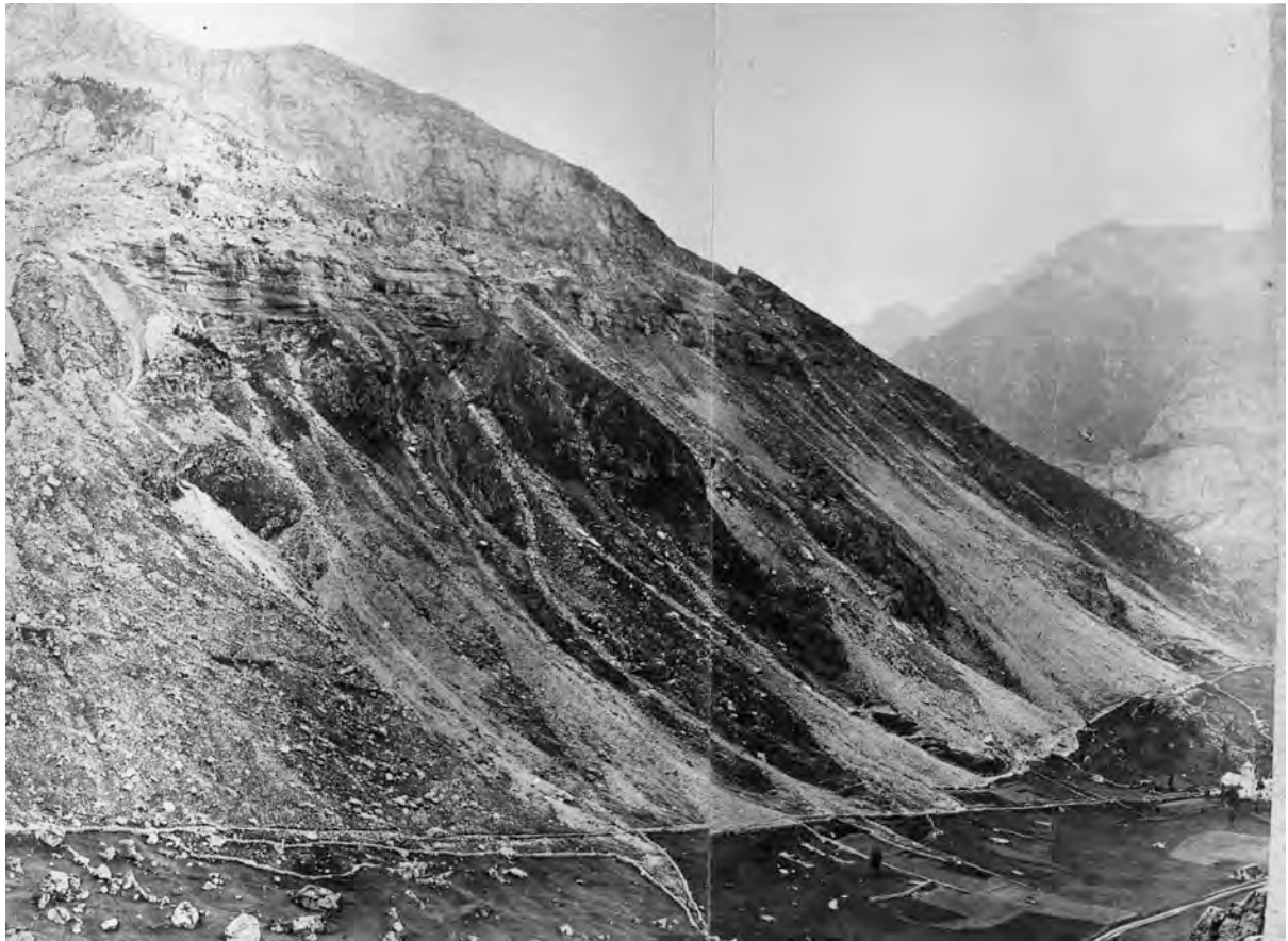
photo 4 : Cliché BARRET, 1890, coll. RTM Hautes-Pyrénées
