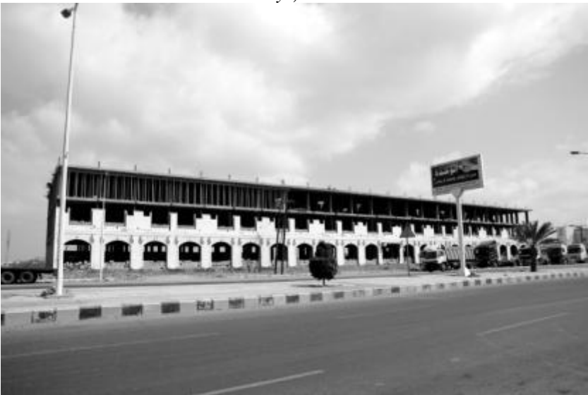
Fig. 5 – Construction d'un complexe commercial à l'entrée de Hodeïda (photo Jamîl Subay')
