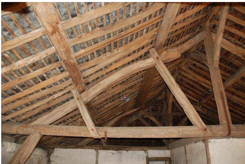
Détail d'une ferme, faux-entrait courbe réemployé en tant qu'arbalétrier
