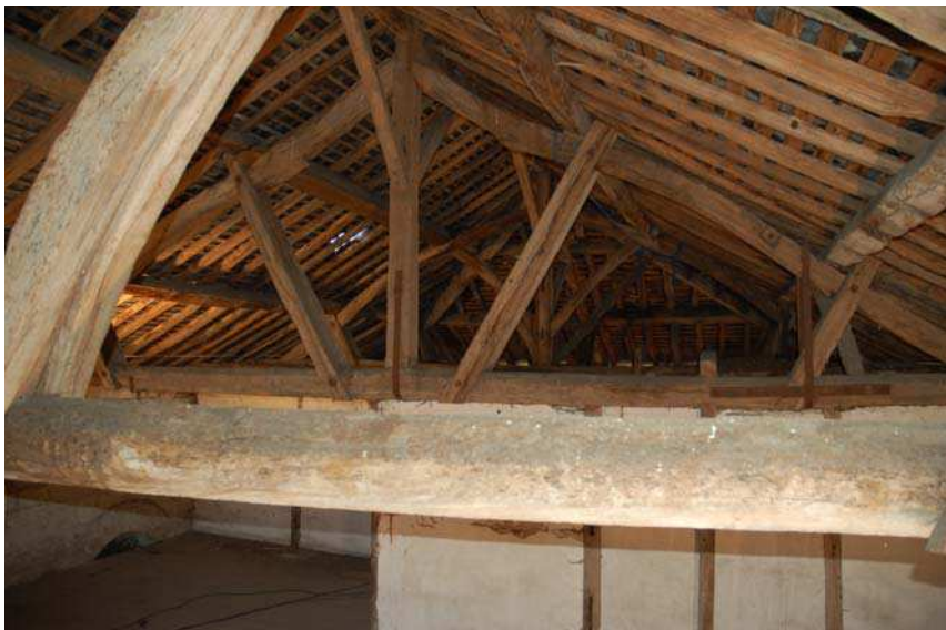
Vue générale de la charpente, vers l'est
