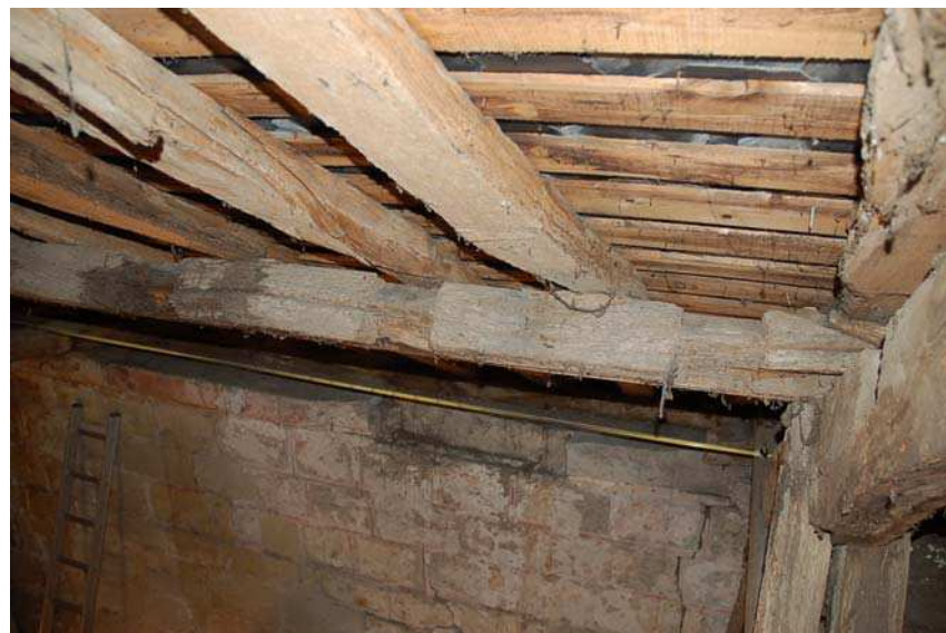
Panne faîtière réemployée en tant que panne
