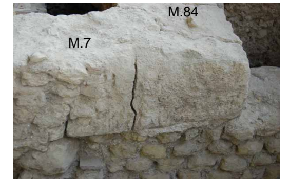
d_Bloc de grand appareil posé de chant servant au chaînage des mur M.84 et M.7.
