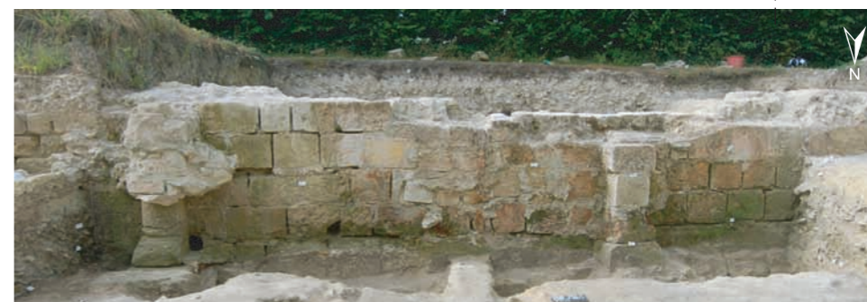
c_Vue d'ensemble de la face nord du mur M.1001.
