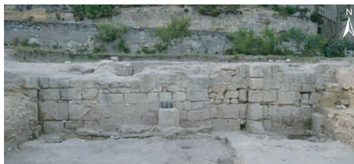
d_Vue d'ensemble de la face sud du mur M.1002.
