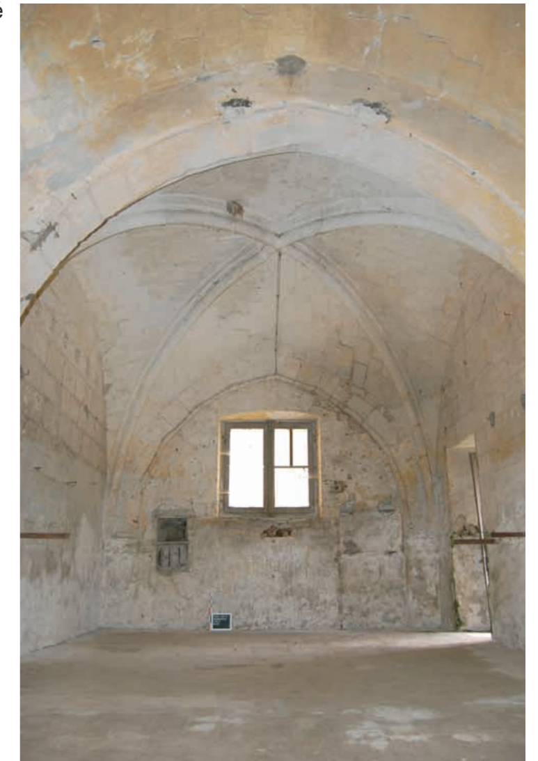
c_Passage occidental ouvert au nord et sud par des arcs brisés (bouchés à l'époque moderne) et couverture en voûtes d'ogive.
