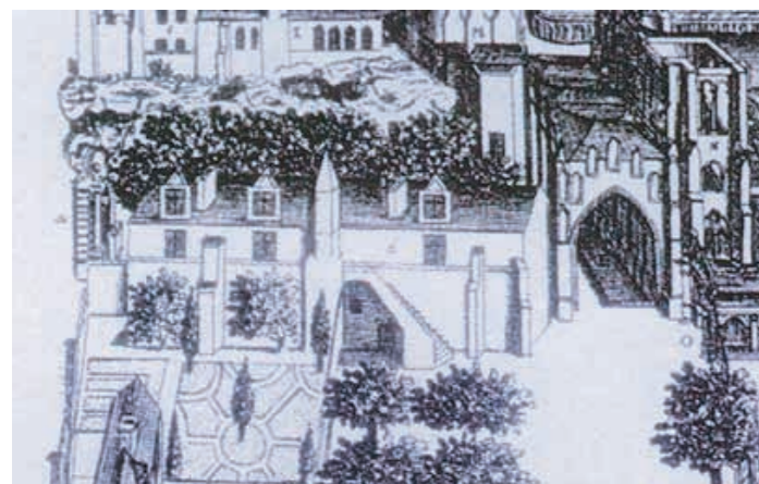
b_ Détail de la vue du Monasticon Gallicanum : le bâtiment de l'hôtellerie avec une tourelle d'escalier au sud.
