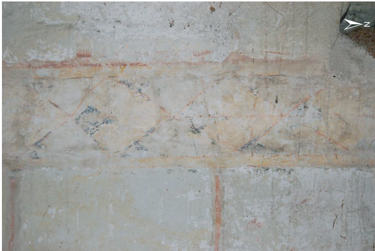
Fig. A : Détail de la frise peinte sur le mur 501, au troisième niveau d'élévation
