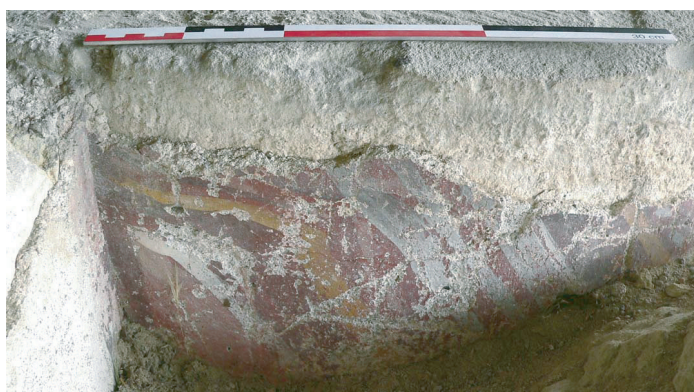
Fig. 15 : Enduit peint roman en place : marbrures sur des piliers de la nef
