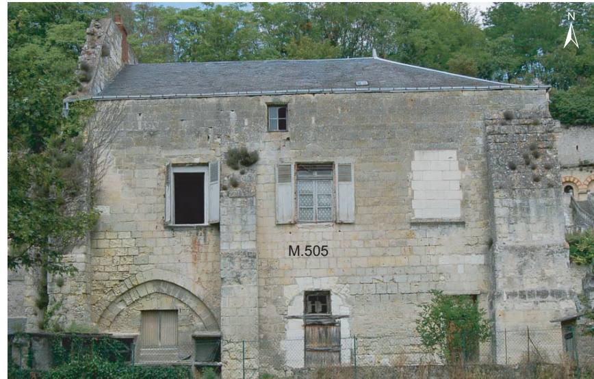
D : Face sud du bâtiment (mur 505)
