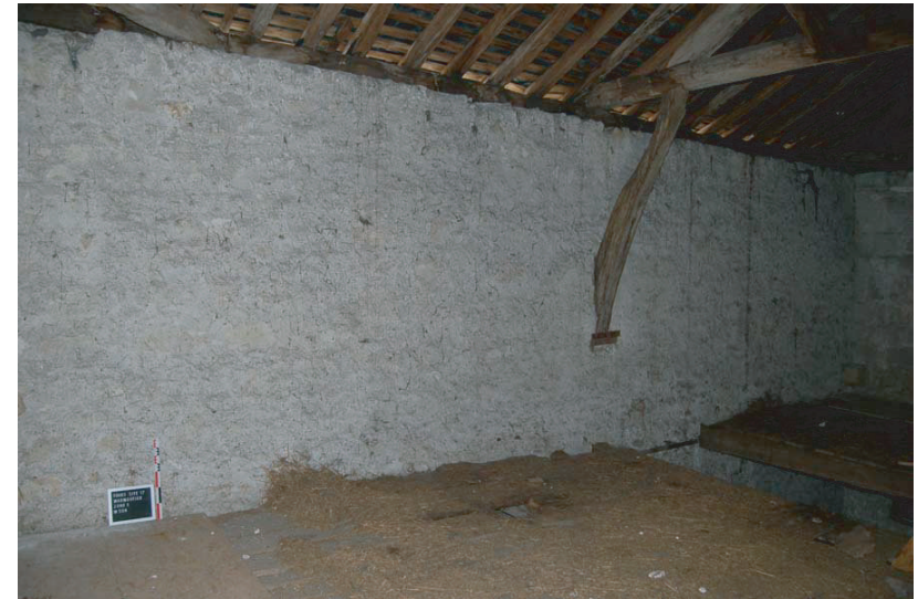
Fig.B : Face intérieure de M.504 : ancrage d'un aisseleur de la charpente au troisième niveau d'élévation
