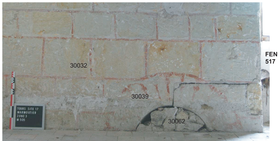
Fig. A : Le décor de faux joints rouges et les faux claveaux de l'OUV 522 (niveau 3)
