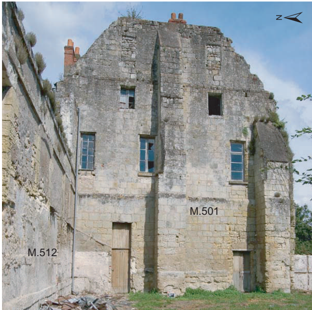
C : Face ouest du bâtiment (mur 501) et mur 512 (mur sud du corps de bâtiment ajouté à l'époque moderne)
