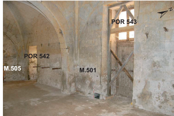
Fig. B : L'extrémité occidentale du bâtiment : le mur 501
