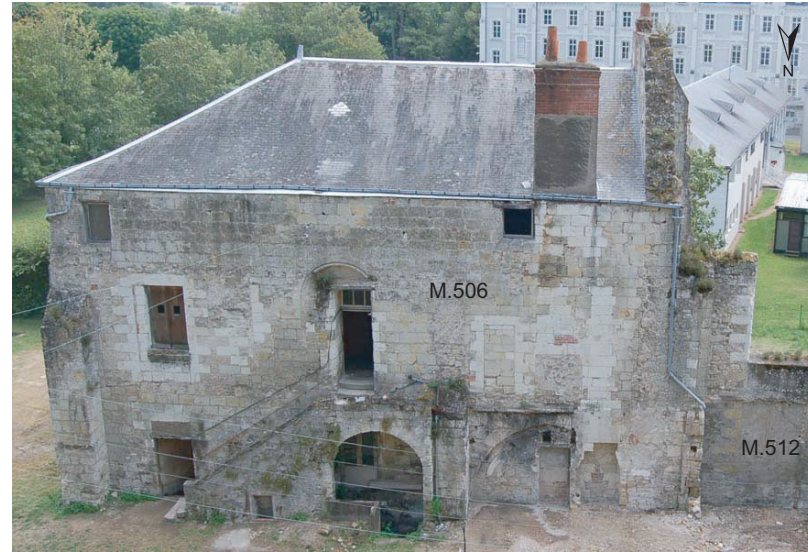
B : Face nord du bâtiment (mur 506)
