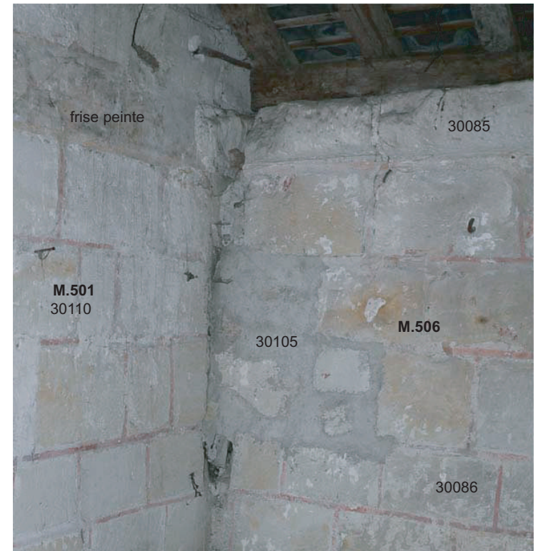
Fig.B : Angle nord-ouest du bâtiment au niveau 3 de l'élévation : décor de faux joints et frise à motifs géométriques au même niveau sur le pignon ouest (M.501)
