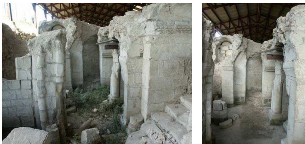
Fig. 18 : La crypte avant et après nettoyage (vues vers l'ouest).
