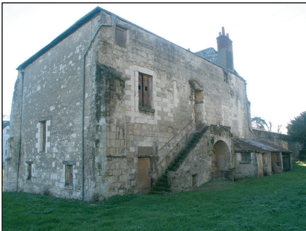
Vue des façades nord et est
