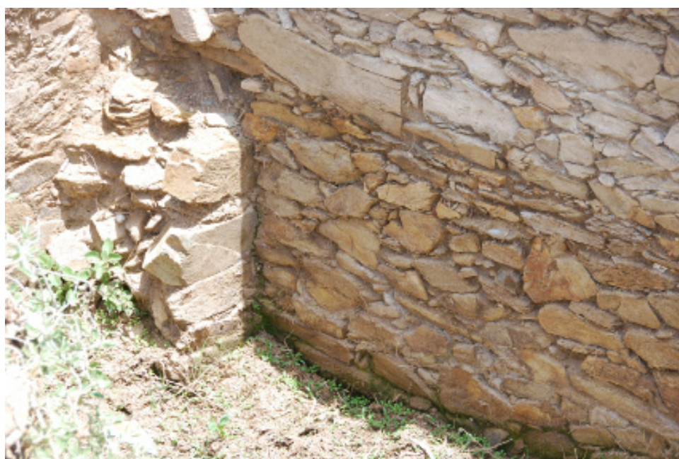
Phot. 2 – Wakarida, fragment de mur en petit appareil régulier émergeant sous les structures du bâtiment dégagé par la population locale (phot. F. Dugast 2010)
