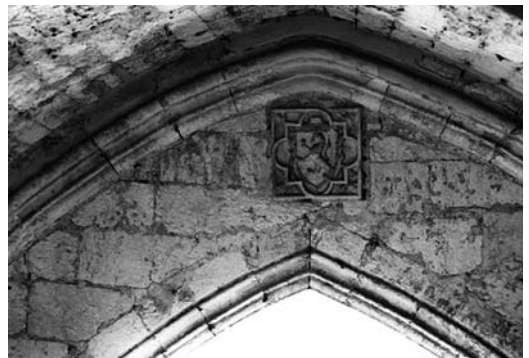
Figura 6 Aparejo y tramos de transición: Tramo 23, nave este: aparejo en disposición horizontal entre los arcos
