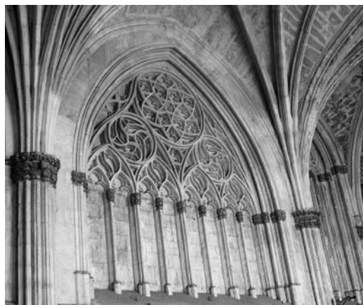
Figura 4 Capilla de San Pedro, interior: arquerías sobre las primitivas azoteas del claustro
