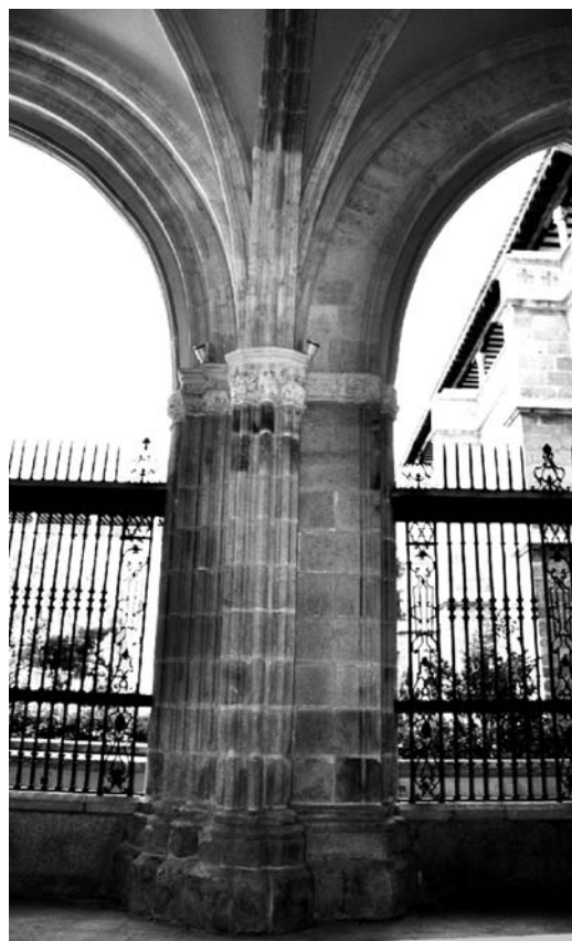
Figura 7 Aparejo y tramos de transición: Tramos 1 (derecha) y 2 (izquierda), nave sur: diferencias arquitectónicas entre la fase primera y la segunda
