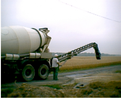
Photo 1 : Camion-malaxeur équipé d'un tapis, que l'opérateur replie
