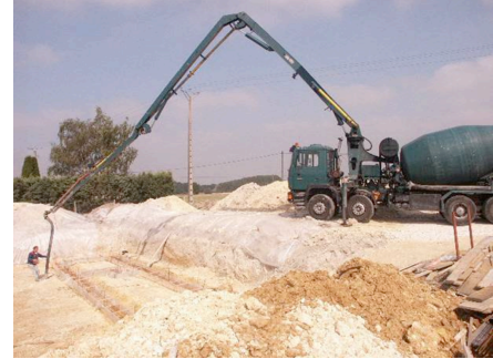
Photo 2 : Mixo-pompe en panne, dont l'opérateur manipule l'embout
