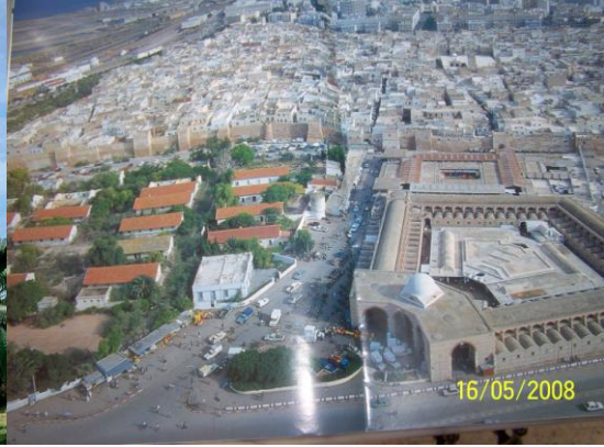
Fig4 : Vue générale des remparts de Sfax
