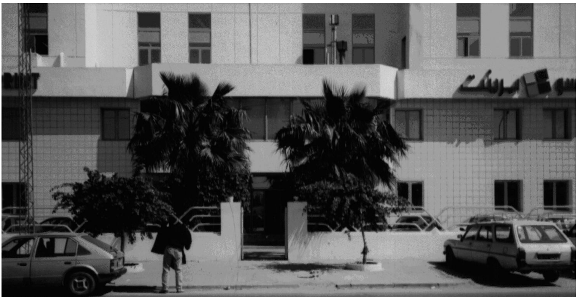
Figure 3: Rénovation de façade
